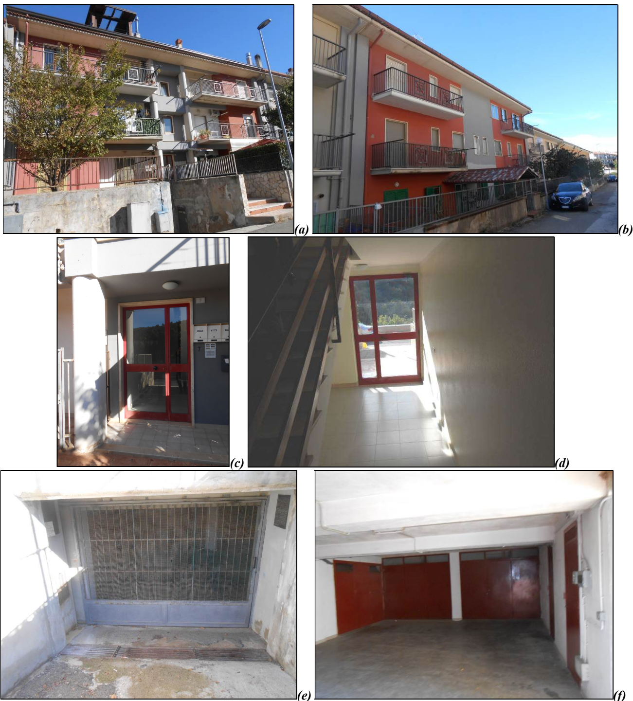
Figura n° 3. Fotografie della palazzina condominiale lotto C3A: prospetto su via Leonardo Cera (a); prospetto su via Donatello Compagnone (b); portoncino condominiale (c); androne e scalinata condominiale (d); cancello e rampa di accesso all'area di manovra (e); area di manovra comune (f).
