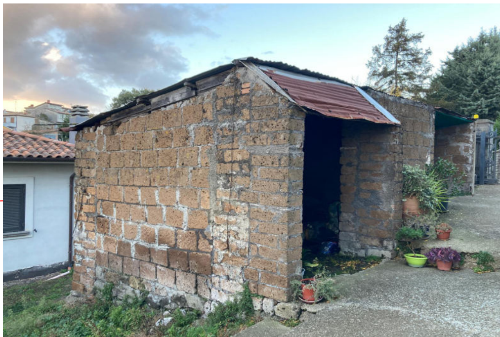
FOTO N. 17 - LOTTO N.1 – locale da demolire
