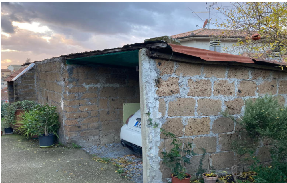
FOTO N. 18 - LOTTO N.1 – locale da demolire
