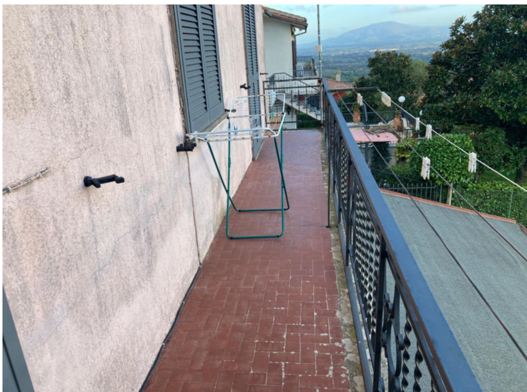
FOTO N. 16 - LOTTO N.2 – balcone
