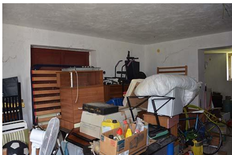
imm2.20: interno del deposito
