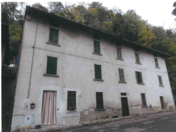
Foto 01 - Prospetto Ovest edificio.JPG
