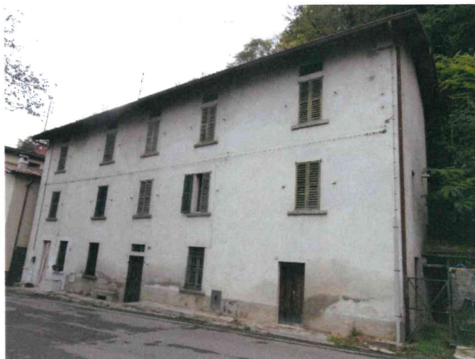
Foto 02 - Prospetti Ovest e Sud edificio.JPG
