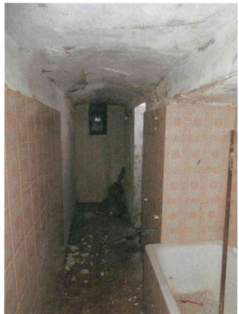
Foto 10 - Bagno porzione sud.JPG
