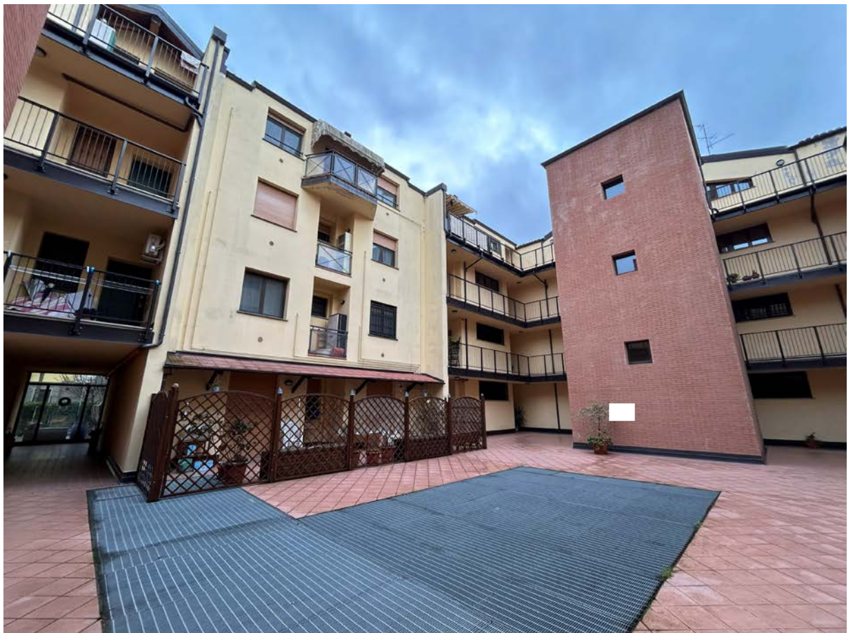
Ripresa fronti interni del condominio
