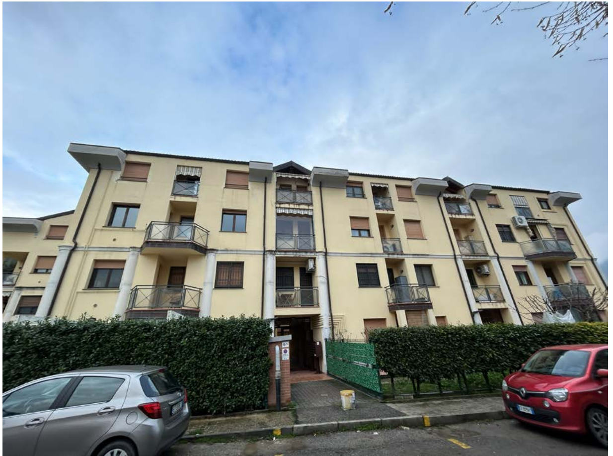
Ripresa ingresso all'edificio fronte ovest
