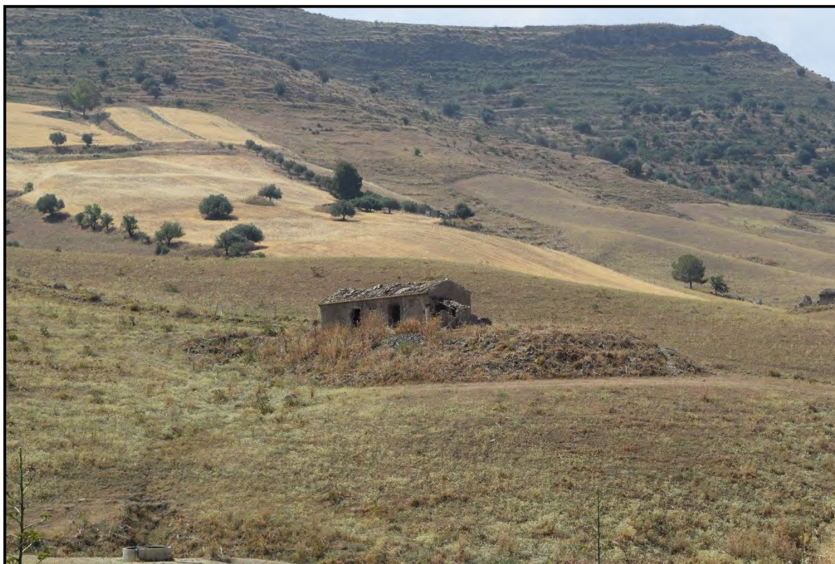
LOTTO 1 – FOTO 9 – CENTURIPPE - Foglio 35 Particella 221 - Vista del fabbricato diruto e catastalmente demolito
