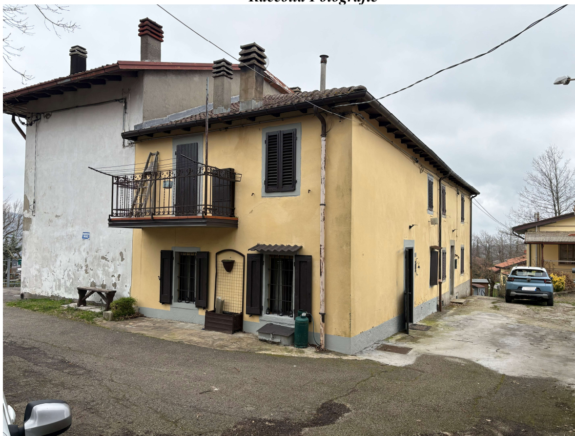
Vista dell'edificio fronte sud est
