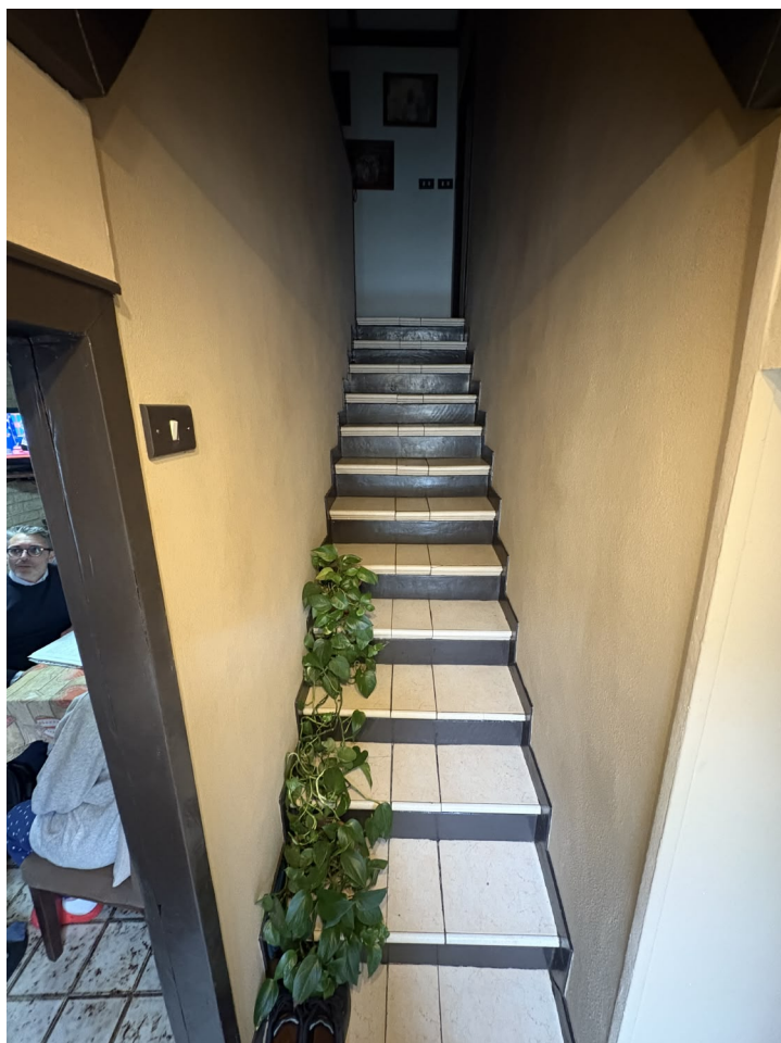
Vista del vano scala
