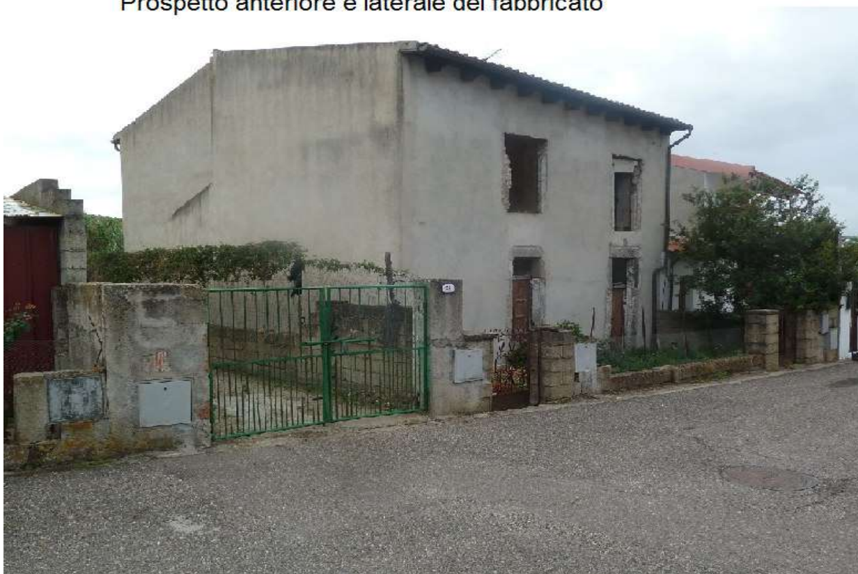
Prospetto anteriore e laterale del fabbricato
