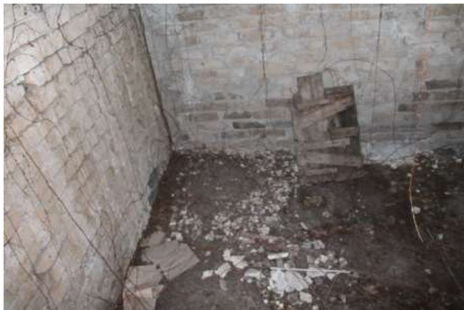
Vista locale seminterrato verso lato sinistro
