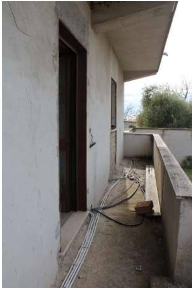
Vista balcone - ingresso immobile
