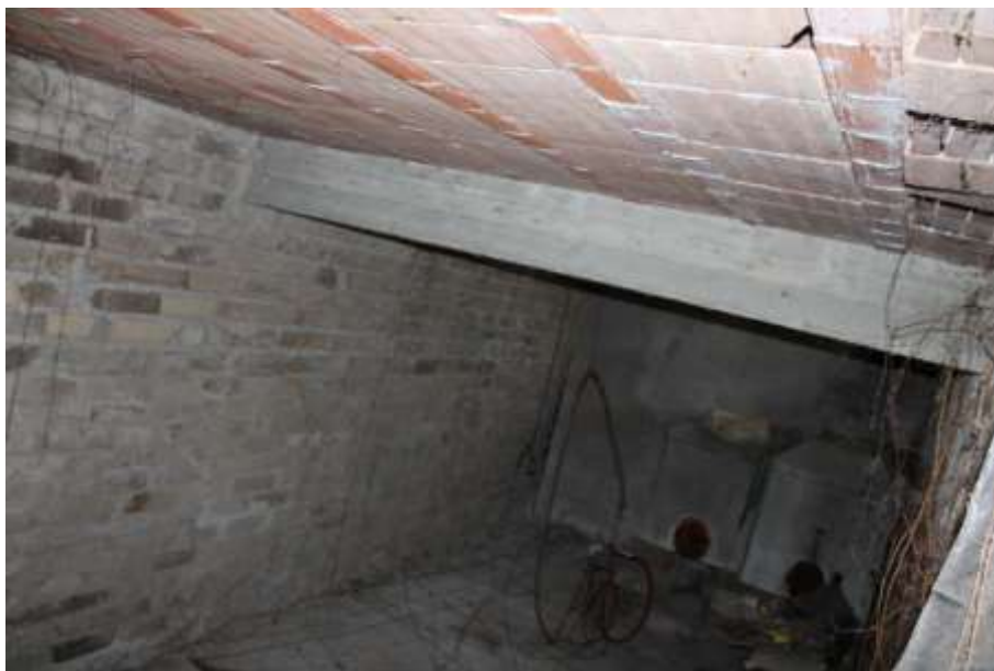
Vista locale seminterrato verso lato destro
