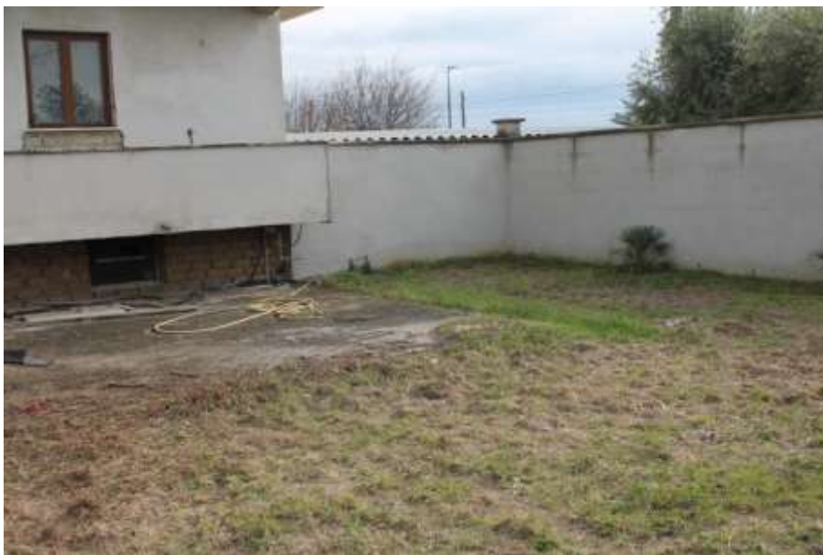
Vista area cortilizia verso lato destro immobile
