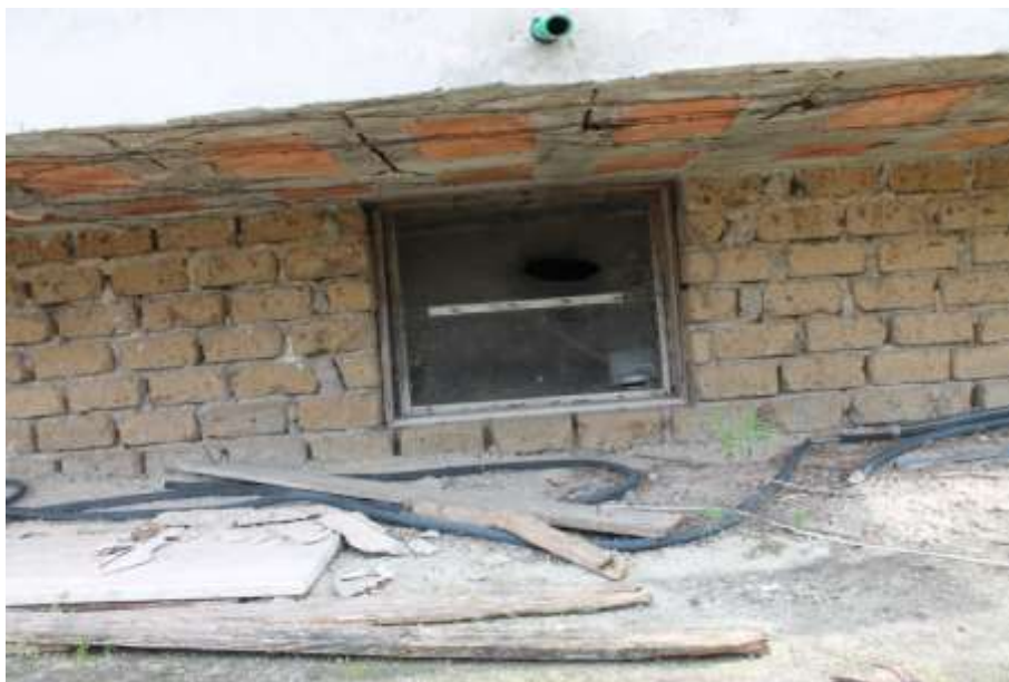
Vista locale seminterrato finestra destra
