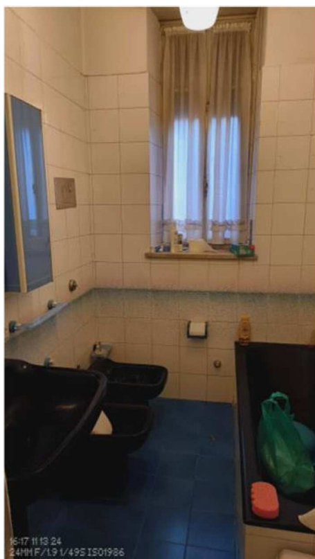
Bagno principale e di servizio/lavanderia
