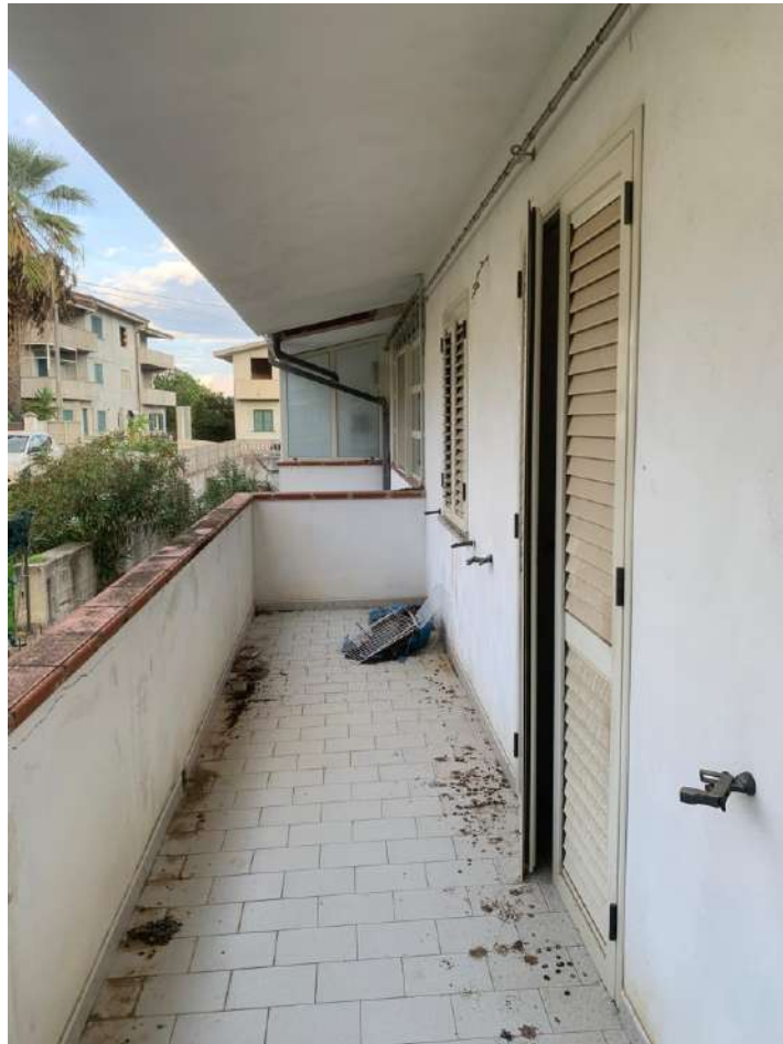
Balcone lato monte
