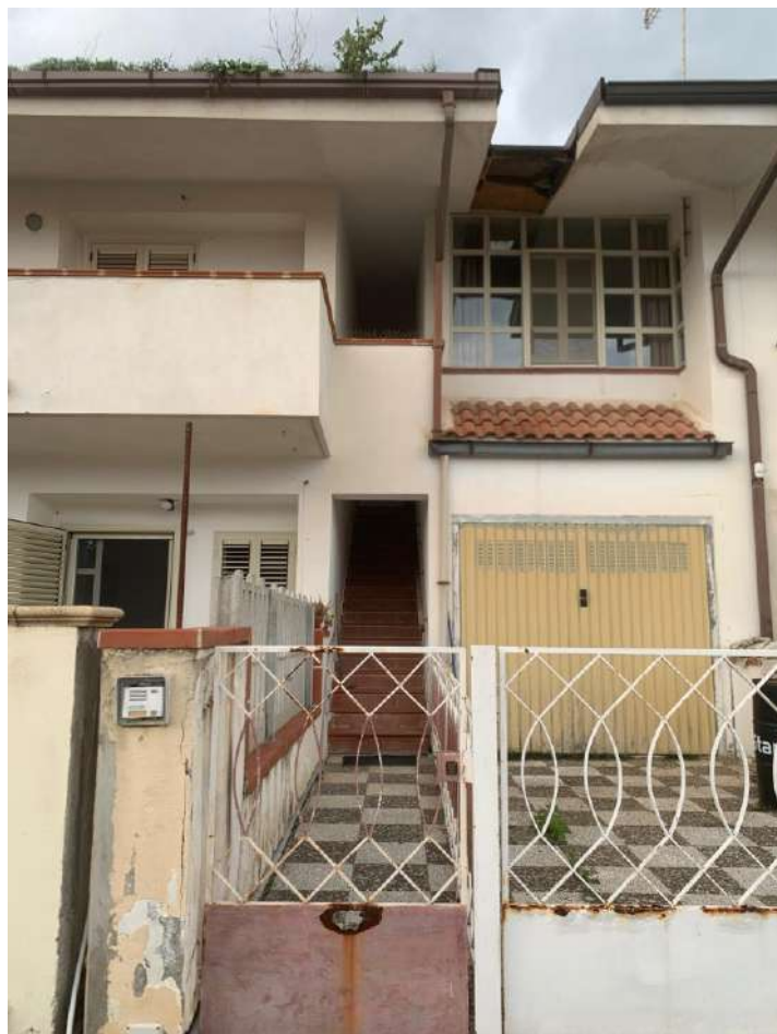
Scala di accesso al piano
