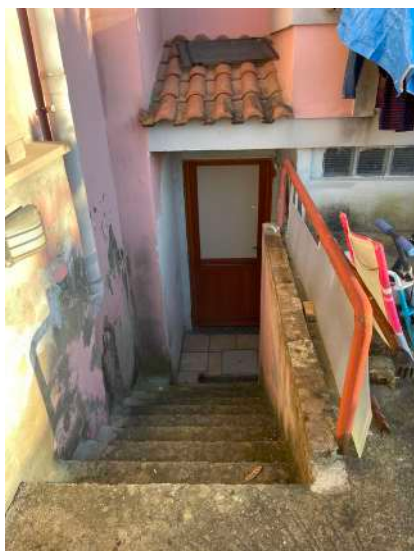
VANO SCALA INGRESSO CANTINA
