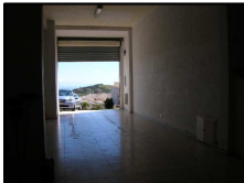
Foto 1 - Porta d'ingresso, vista esterna.
