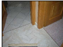
Foto 10 - Cucina, vista interna.
