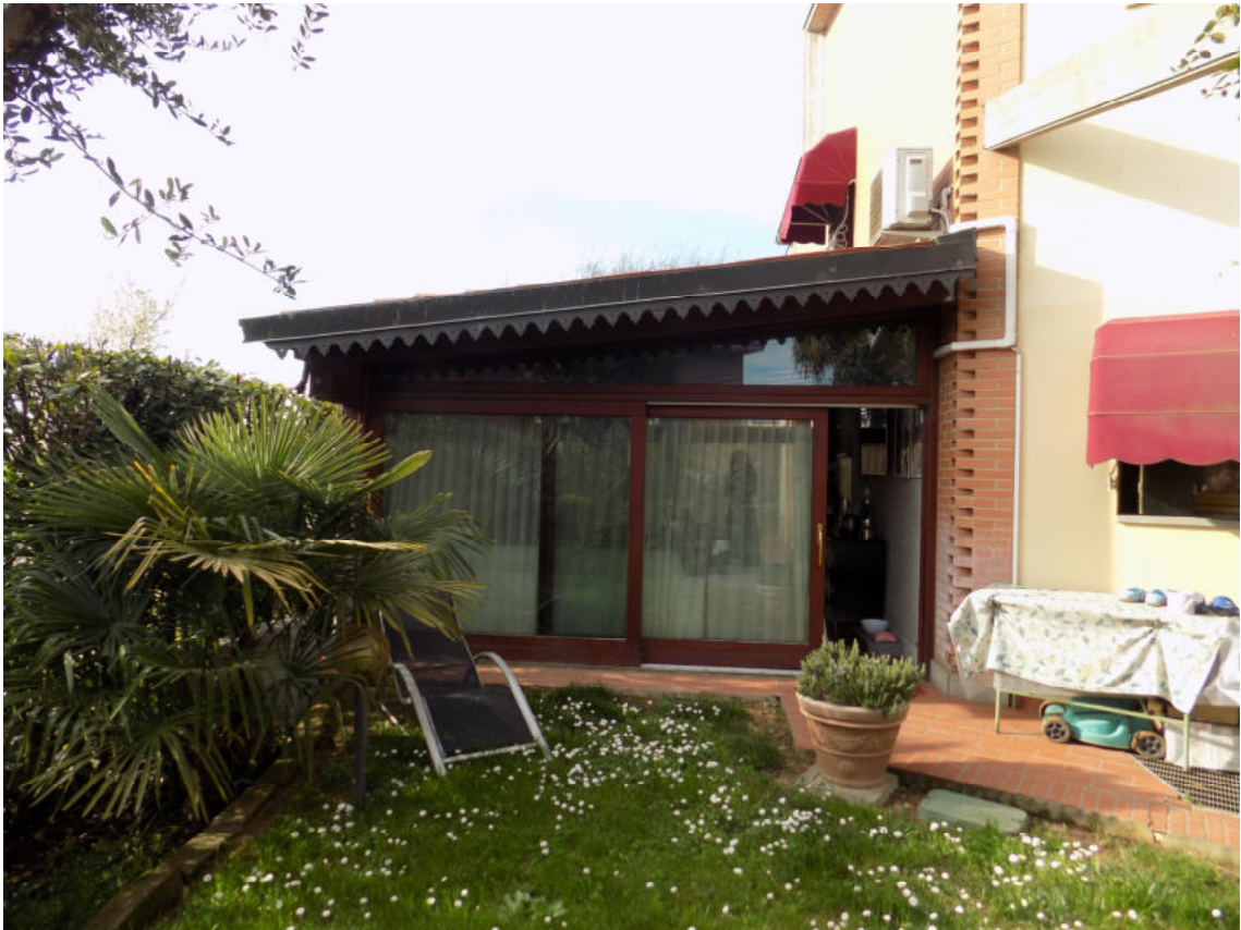
vista veranda da Sud
