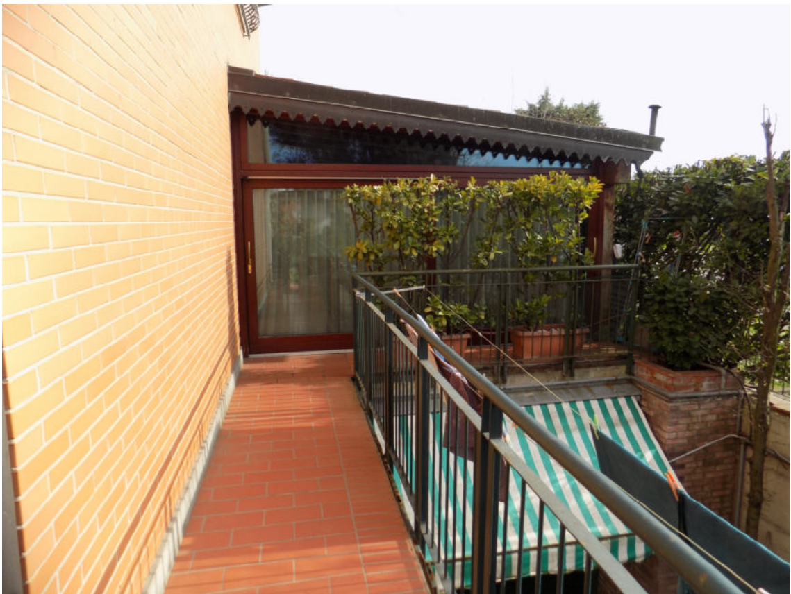
veranda esterna illegittima
