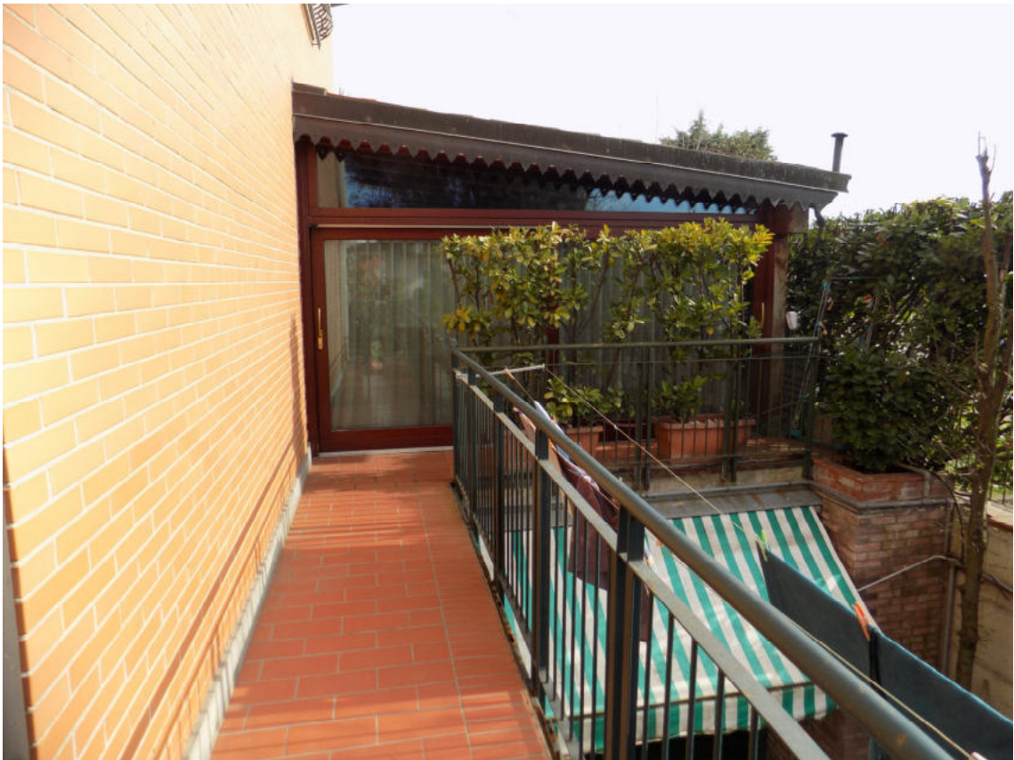
veranda esterna illegittima
