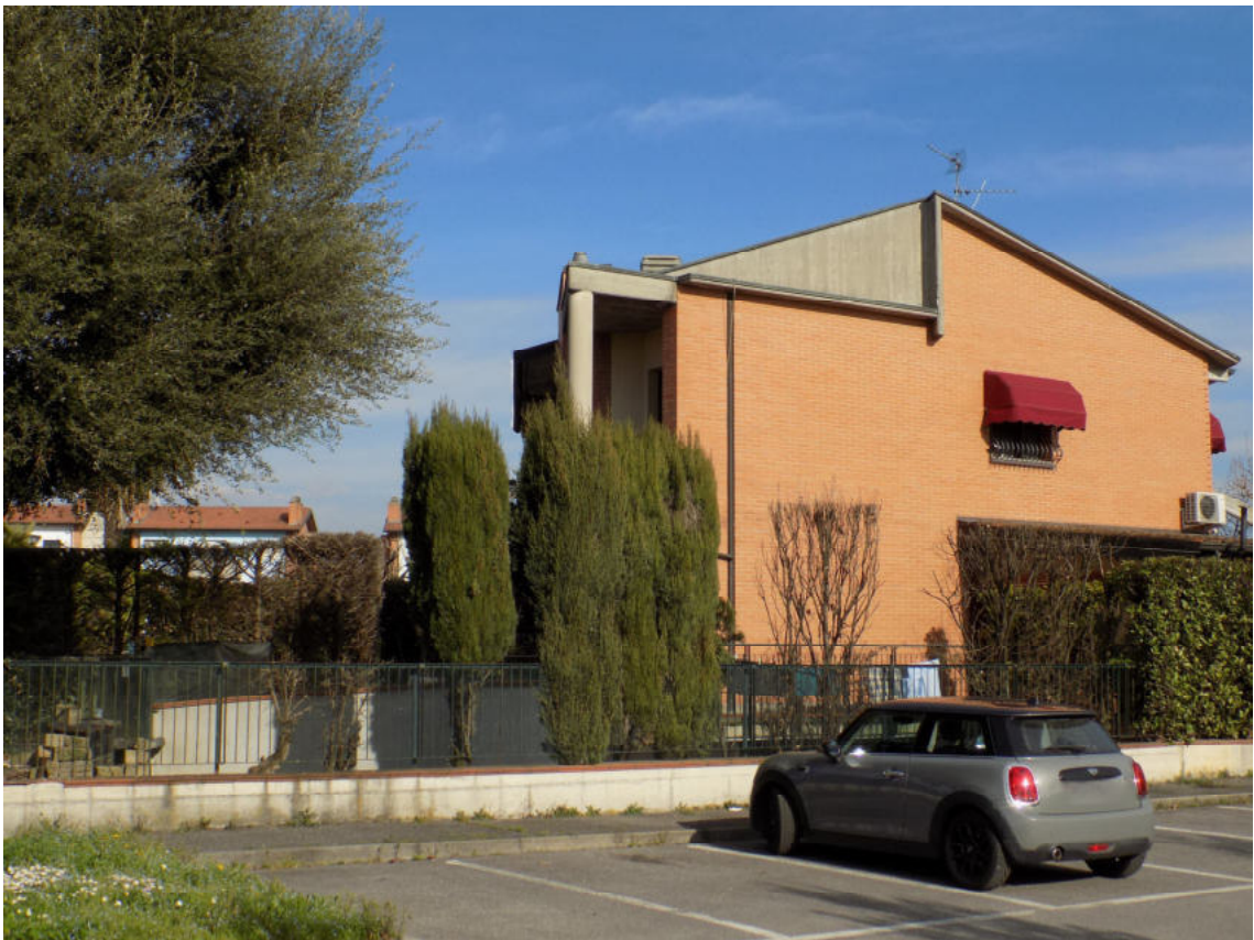
vista da Ovest
