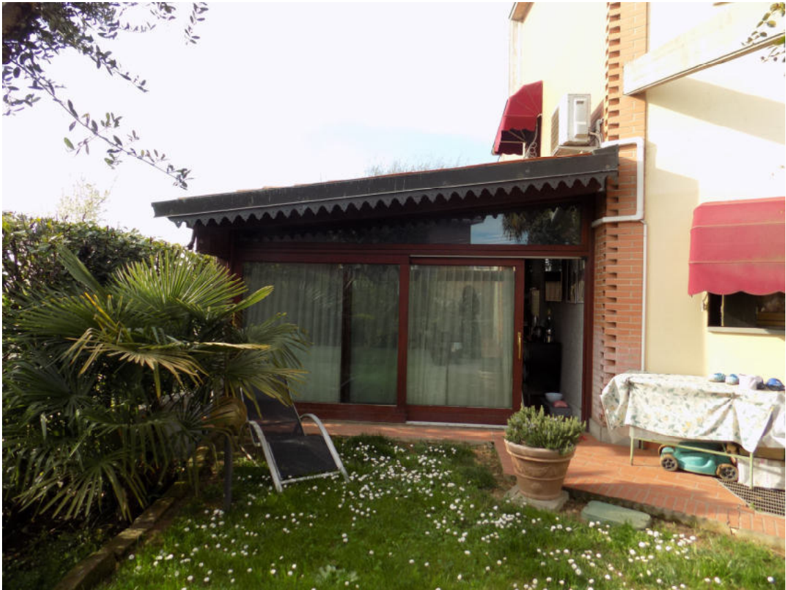
vista veranda da Sud
