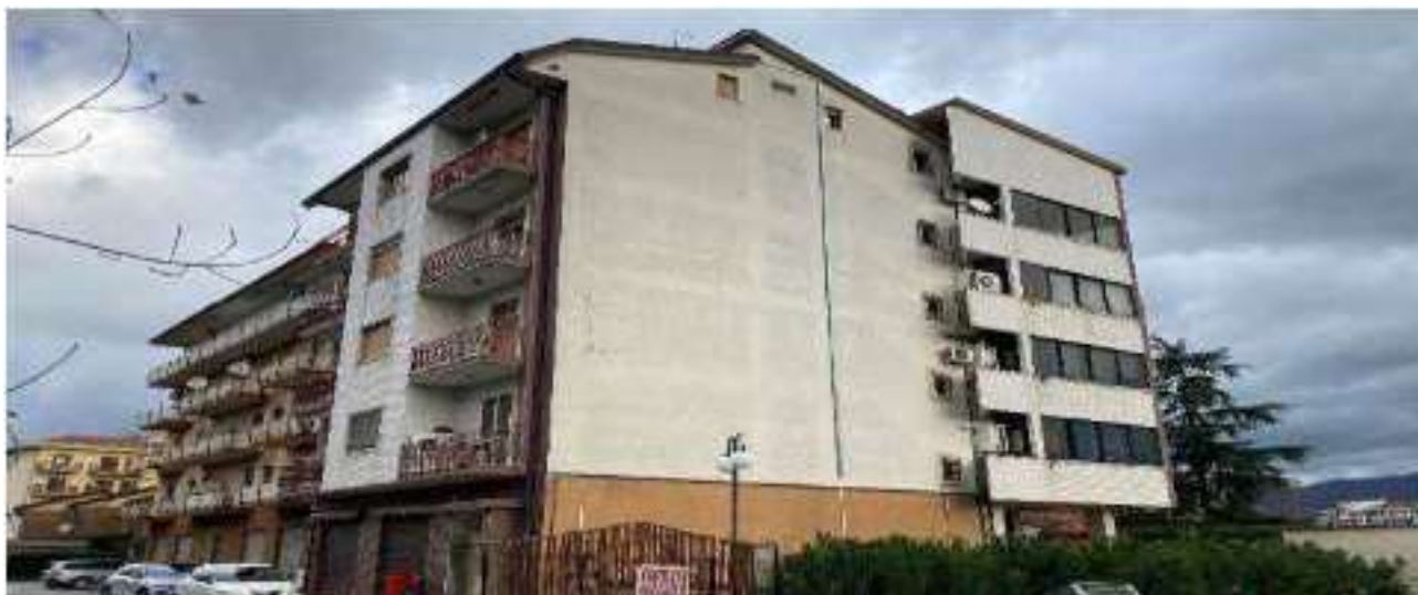
Vista prospettica lato Sud
