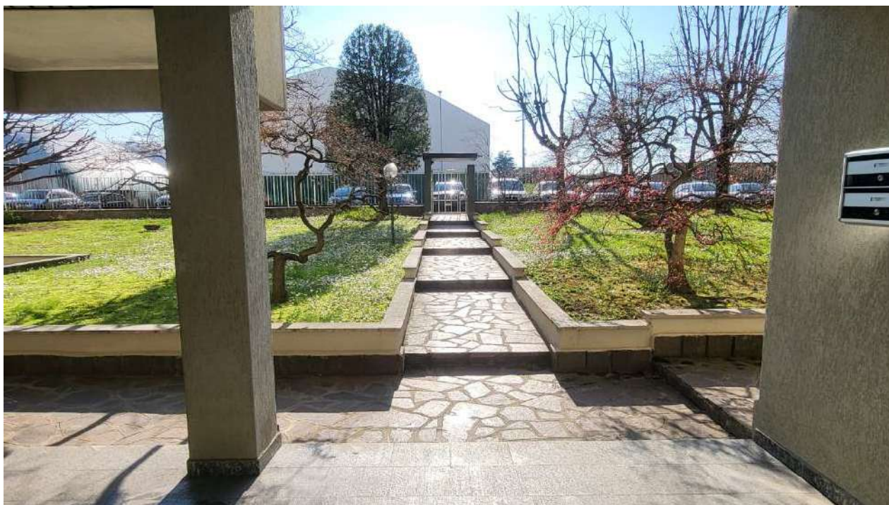
Scala di collegamento tra la Pubblica Via e l'atrio d'ingresso dell'edificio
