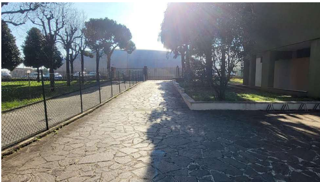
Rampa di accesso all'autorimessa condominiale
