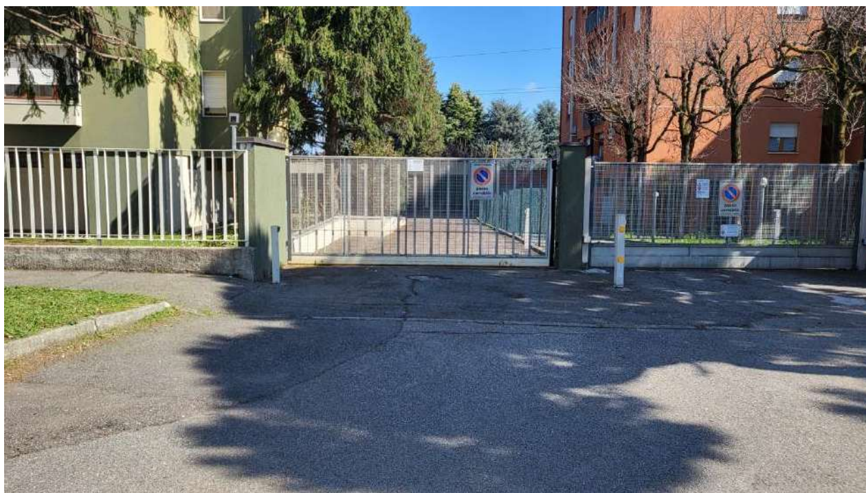
Ingresso carroia dell'edificio
