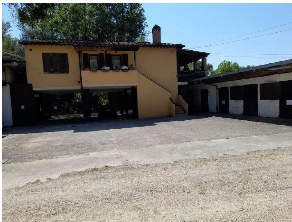
Fabbricato A-prospetto ovest
