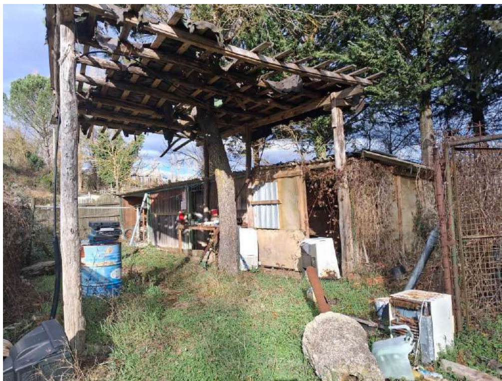
Manufatto da demolire
