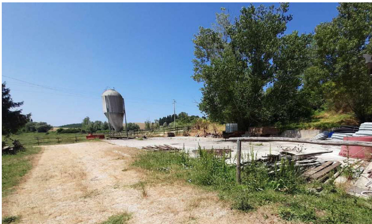
Platea da demolire
