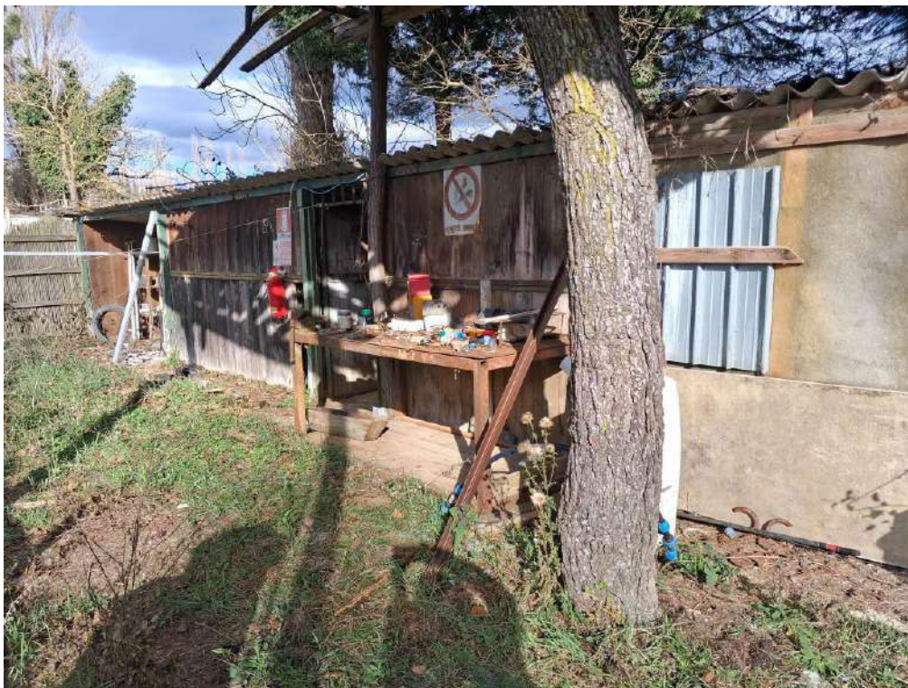
Manufatto da demolire
