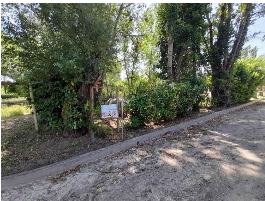
Area deposito gpl
