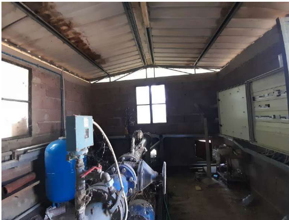
Fabbricato alloggio pompa
