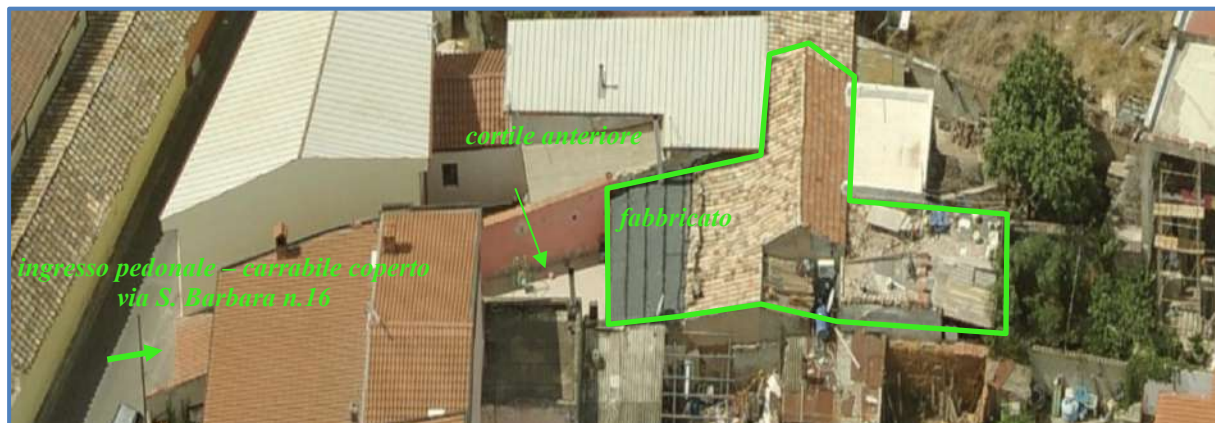
Foto n°5 - Vista aerea obliqua laterale dell'immobile
