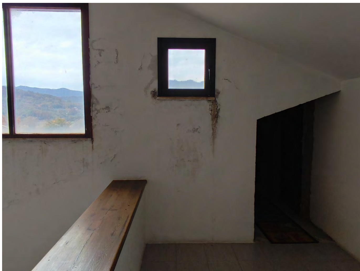
Ingresso da Vano Scala
