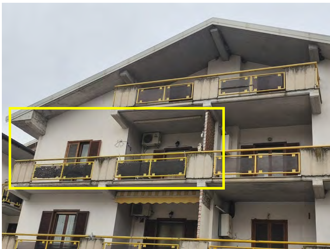
Corpo A : abitazione
