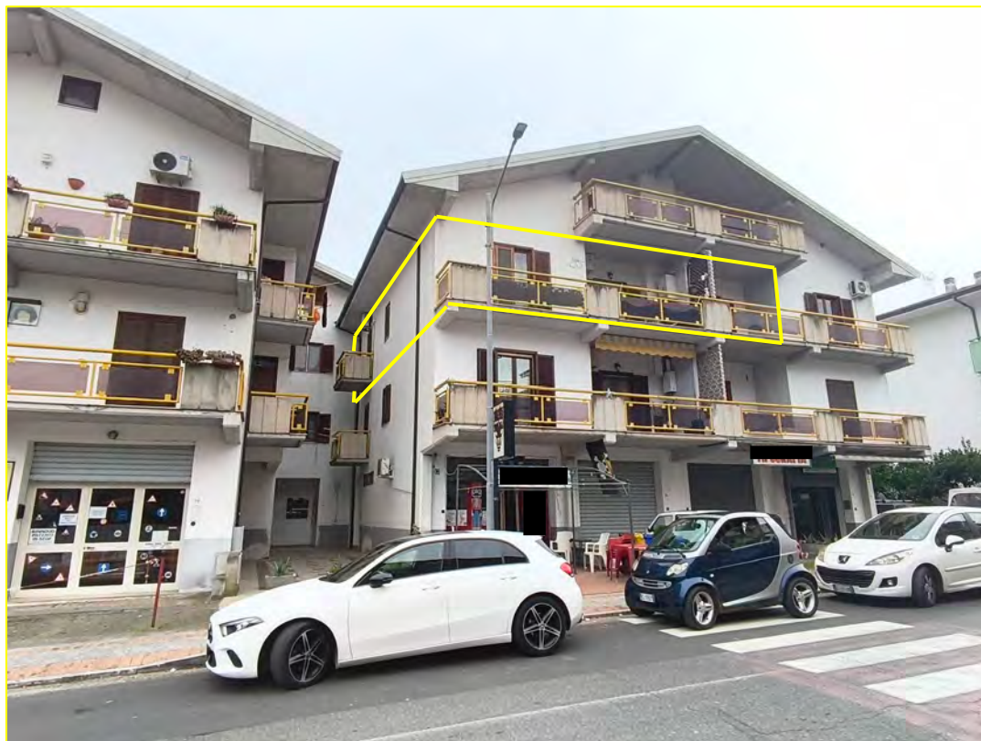
Prospetto Lotto 1 da Via Piano Della Fiera
