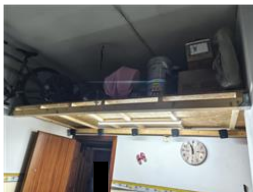
Veduta interna - Particolare Soppalco
