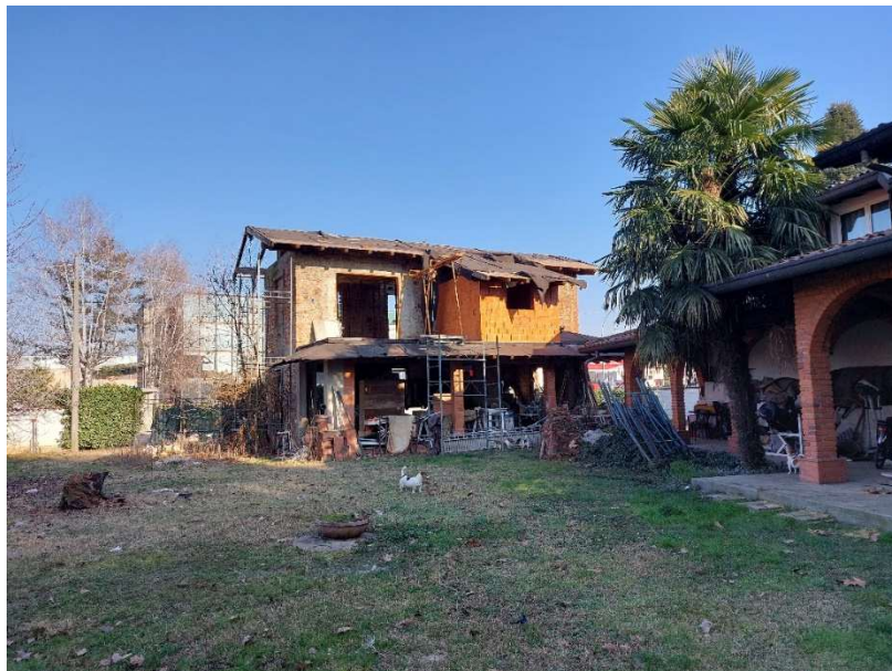
Scorcio da nord-ovest con fabbricato da demolire
