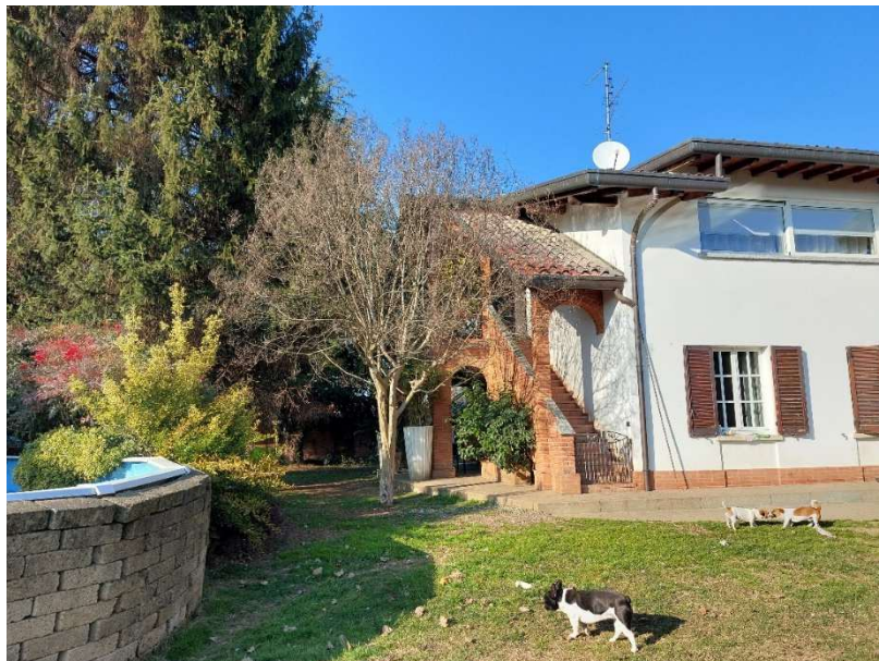
Vista da sud ovest con scala accesso a primo piano
