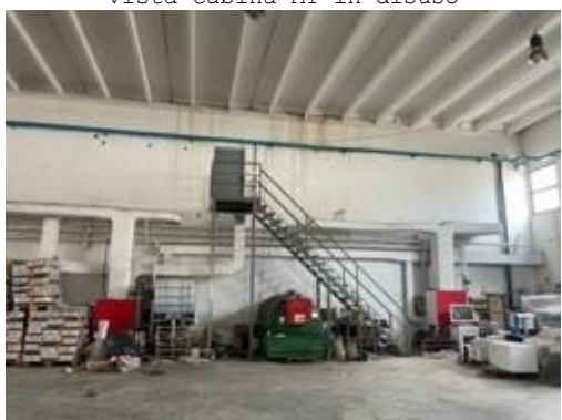
Vista scala comunicazione tra uffici e capannone
