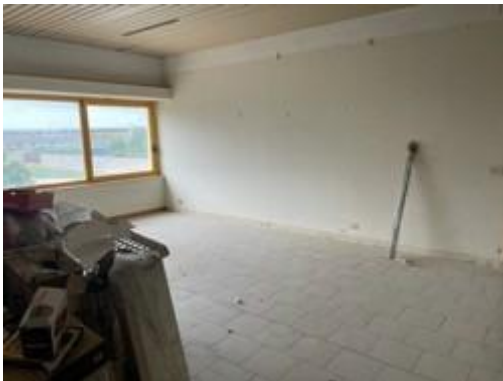
Vista zona piano 1 appartamento custode
