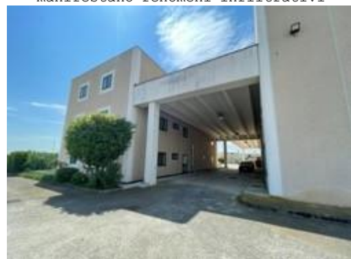
Vista posteriore palazzina uffici
