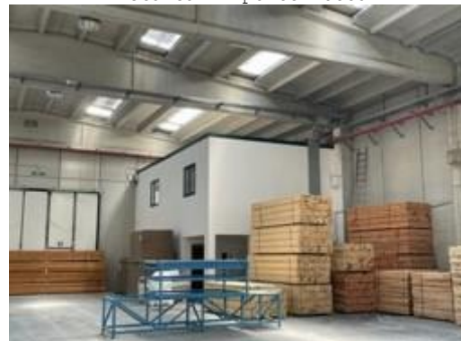
Vista zona bagni 1 interna lotto
