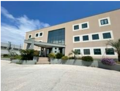
Vista esterna anteriore uffici
