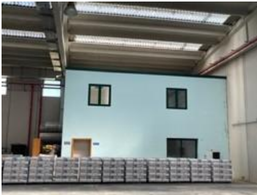
Vista zona bagni 2 interna lotto
