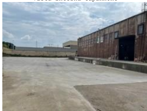
Vista zona di carico/scarico
