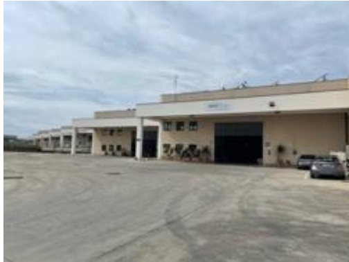
Vista esterna lotto
