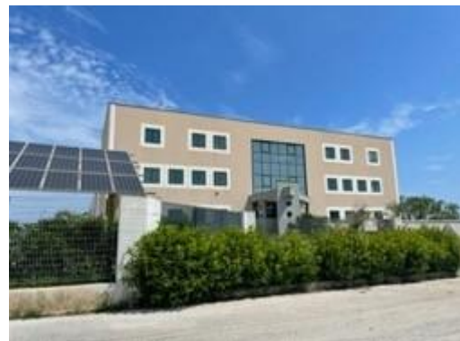
Vista fotovoltaico a terra lotto 1
