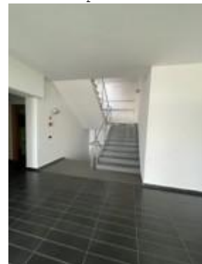
Vista scale palazzina uffici
