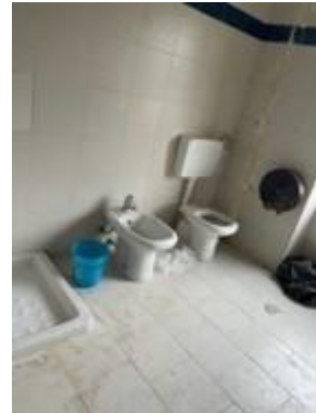
Vista zona bagni piano 1 appartamento custode
