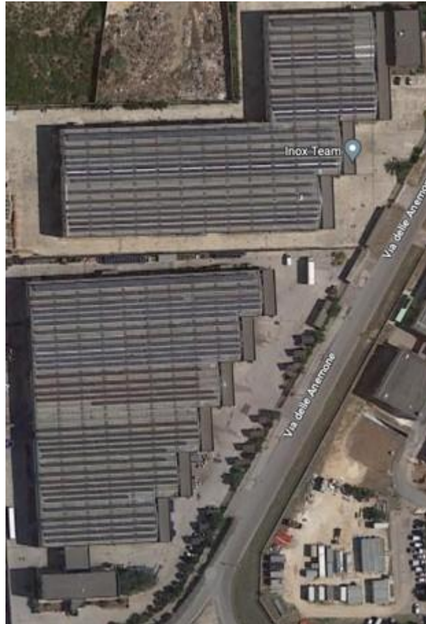
Vista satellitare impianto fotovoltaico posto sul tetto del lotto 1 e lotto 2
