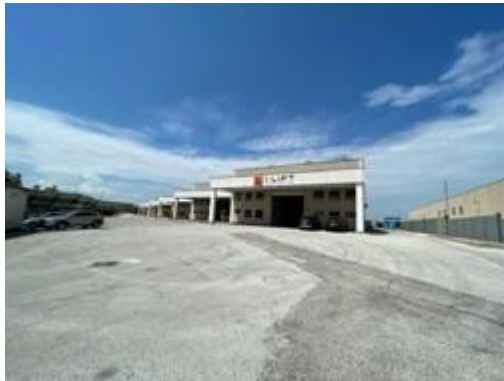
Vista esterna locato ad I-LIFT
