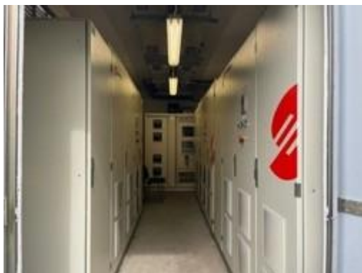
Vista cabina per inverter fotovoltaico
