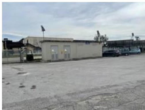
Vista esterna cabina inverter allocata nel lotto 1
