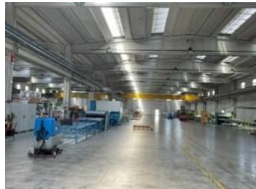
Vista carri ponte lotto
