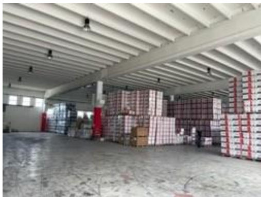
Vista interna capannone
