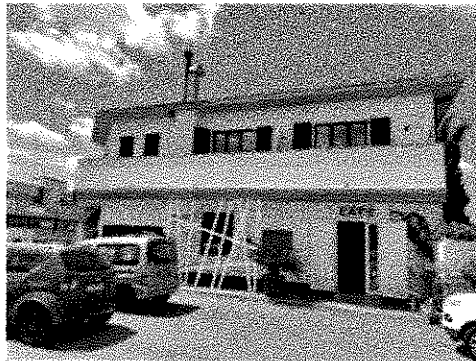
prospetto sud sulla via provinciale
