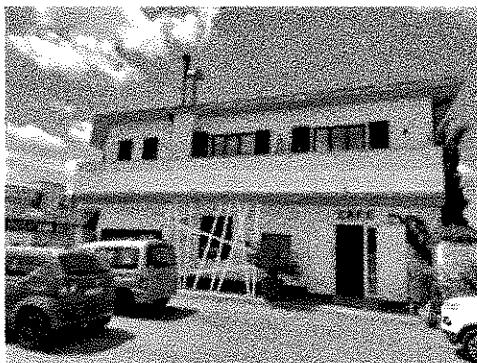
prospetto sud sulla via provinciale
