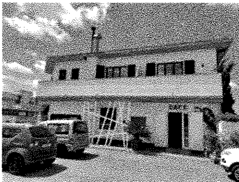
prospetto sud sulla via provinciale
