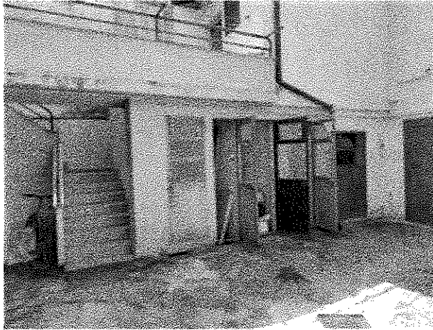
Prospetto nord sul cortile comune da cui si ha l'accesso
