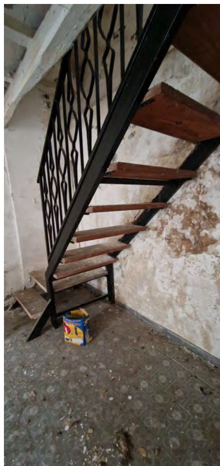
Scala accesso al Piano Secondo
