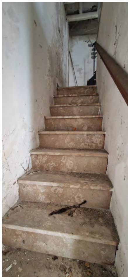
Scala di accesso al Piano Primo
