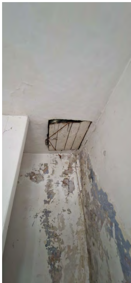
Botola di accesso al sottotetto
