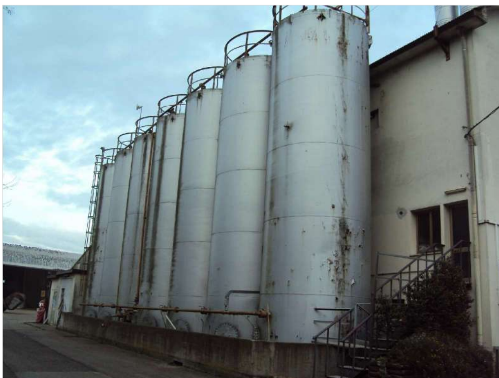
Rif. n. 5v: Silos per olio vegetale da 600 q.li (in corso di revisione)
