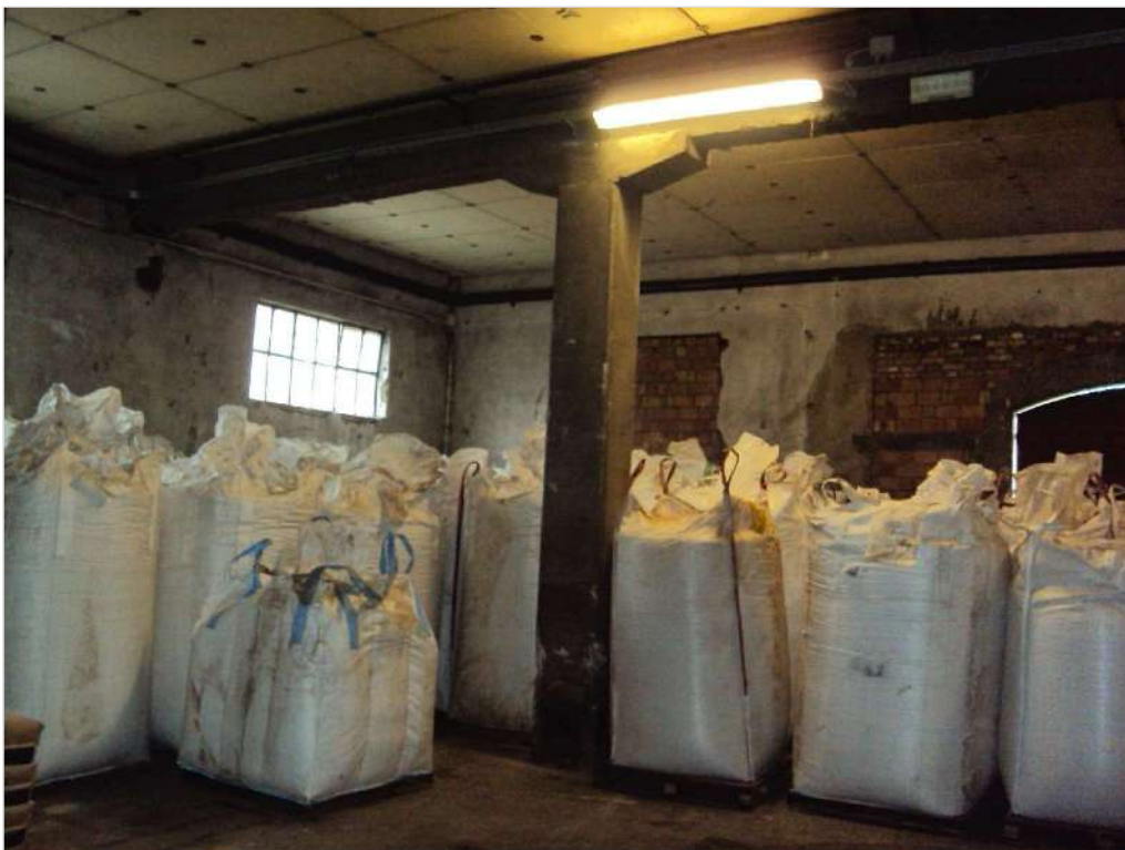
Foto n. 6: Interno corpo A1
