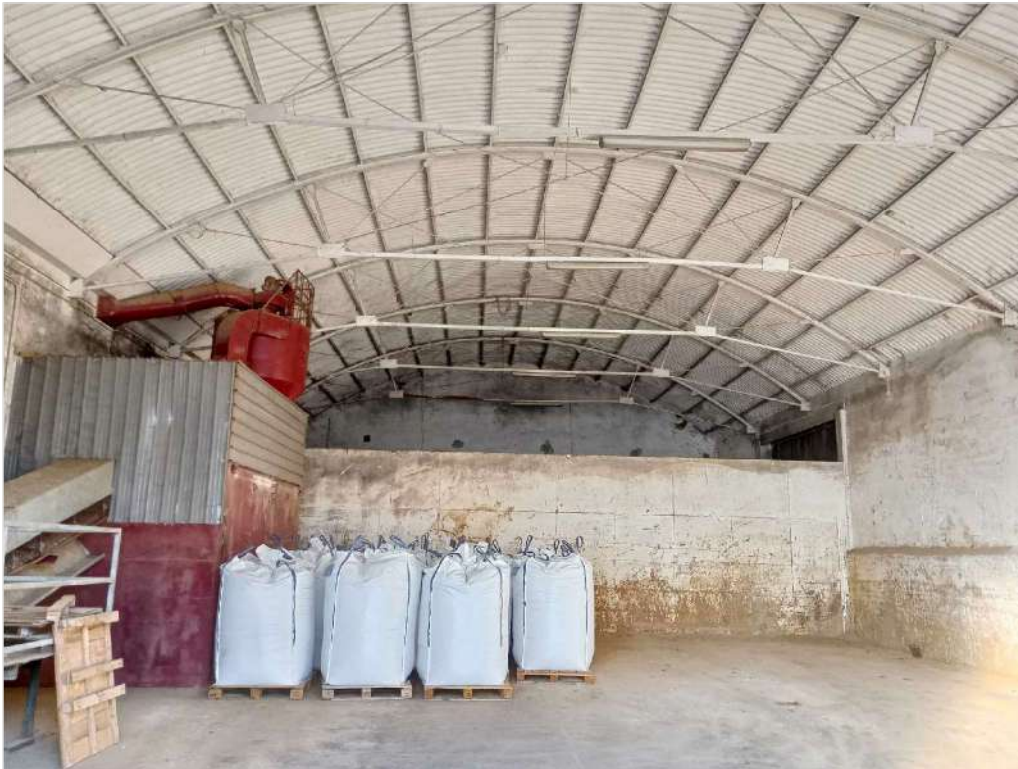
Foto n. 19: Interno corpo B2
