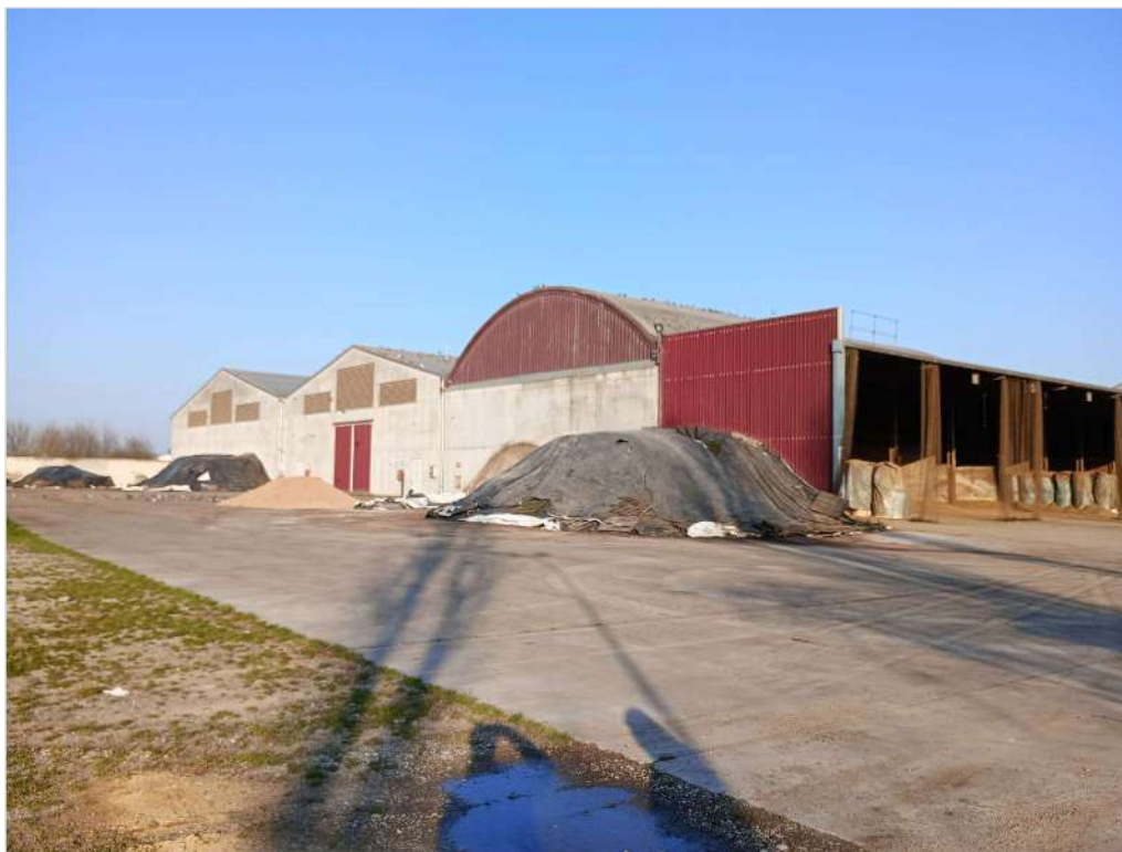
Foto n. 56: Area scoperta lato ovest
