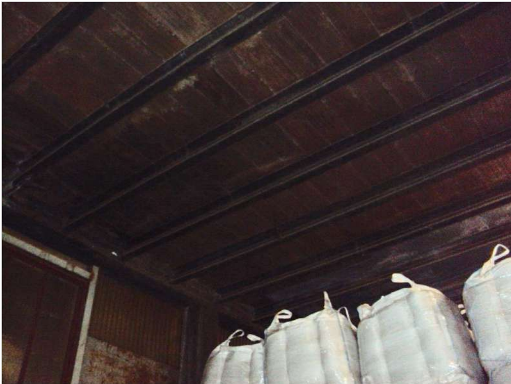
Foto n. 8: Interno corpo A1
