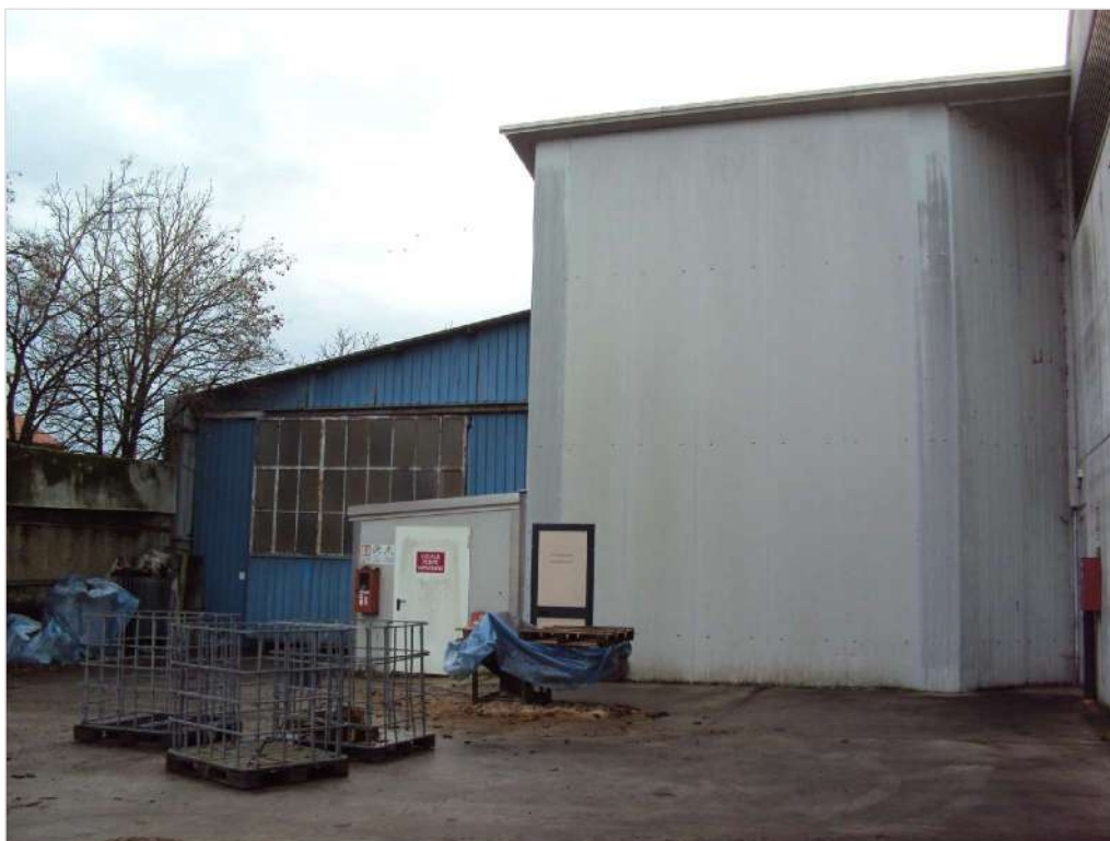
Foto n. 50: Locale impianto antincendio, fabbricato H
