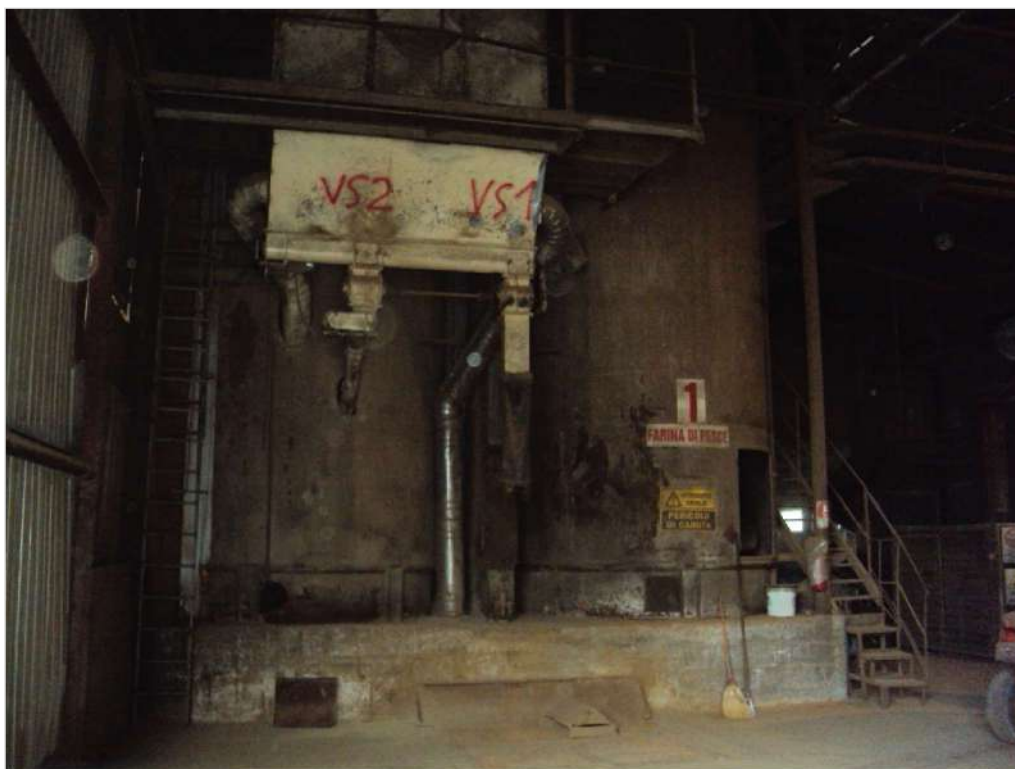
Foto n. 28: Interno corpo D1
