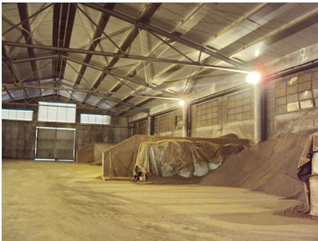
Foto n. 43: Interno corpo H1
