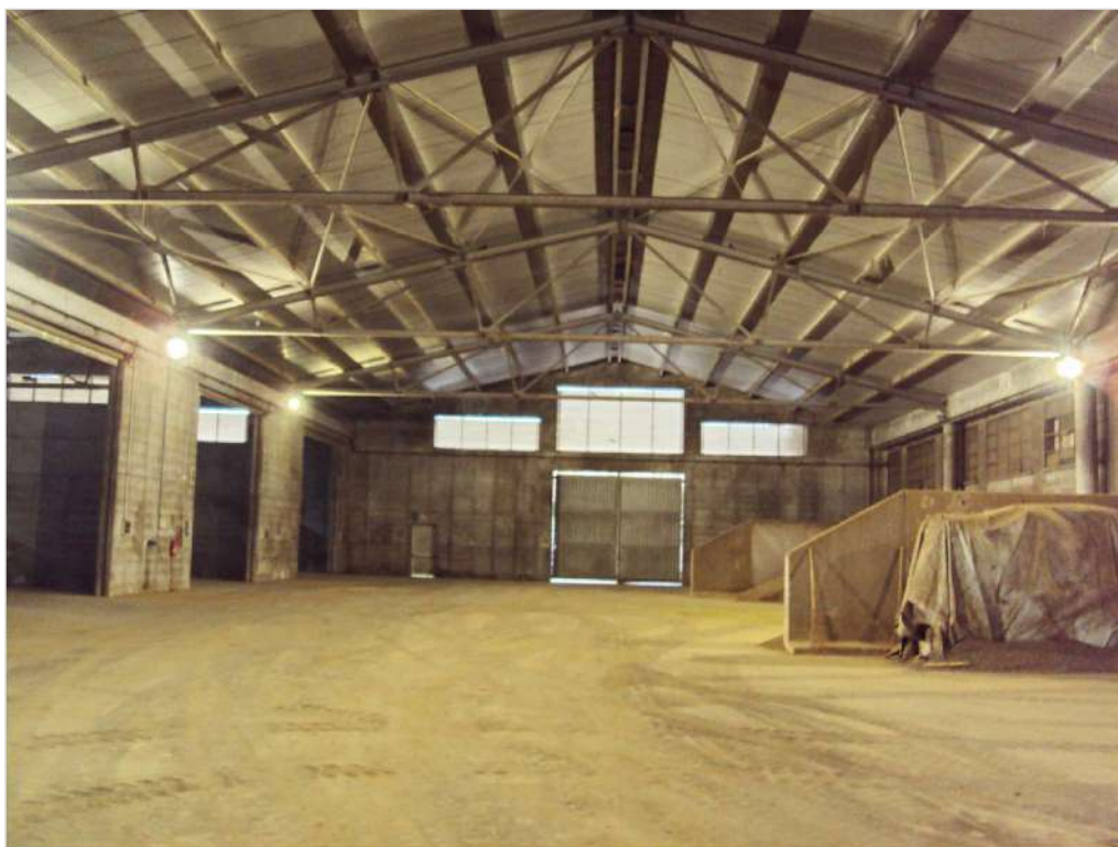
Foto n. 44: Interno corpo H1
