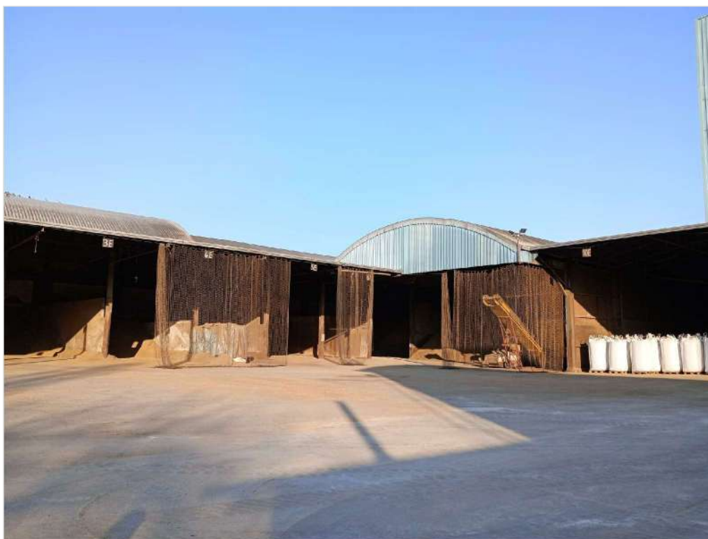
Foto n. 30: Prospetto ovest fabbricato F
