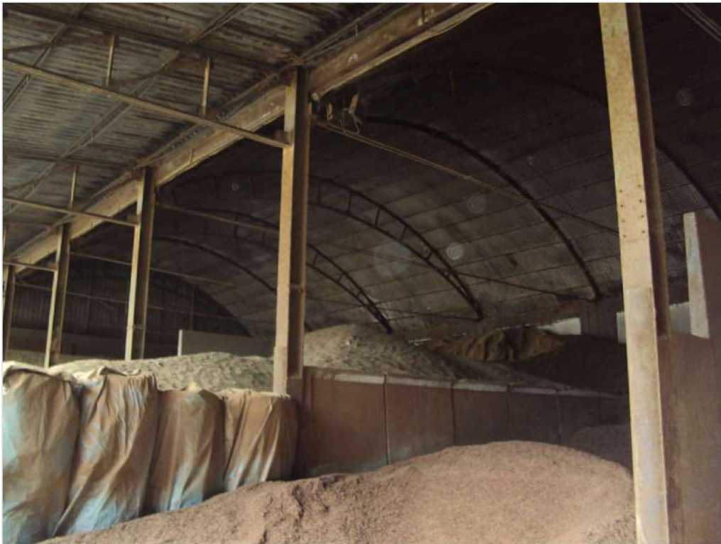
Foto n. 36: Interno corpo G1
