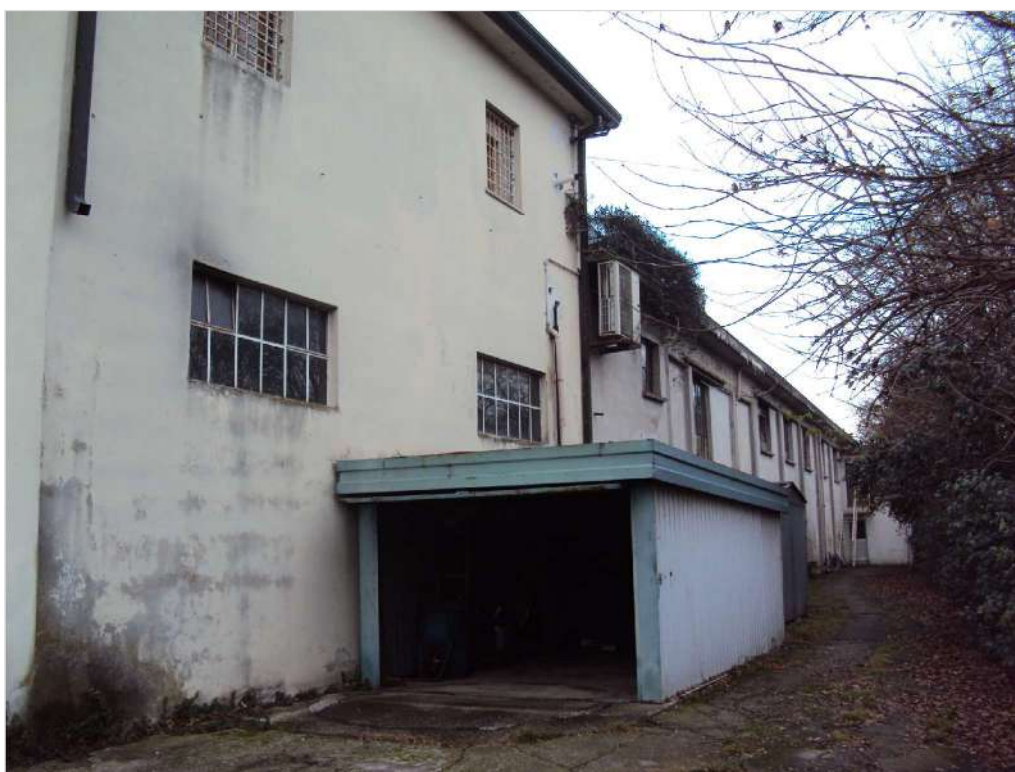
Foto n. 49: Box autorimessa adiacente al fabbricato A
