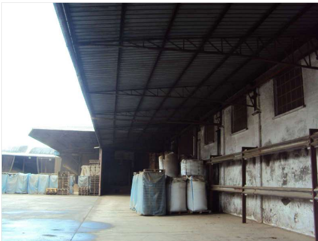
Foto n. 22: Pensilina C2 lato ovest
