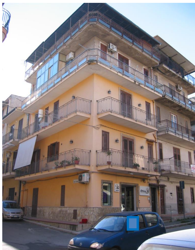
Veduta d'angolo del I° e II° piano tra viale Europa e via Pirandello
