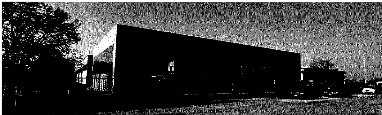
Figura 4: esterni (vista da nord-est)
