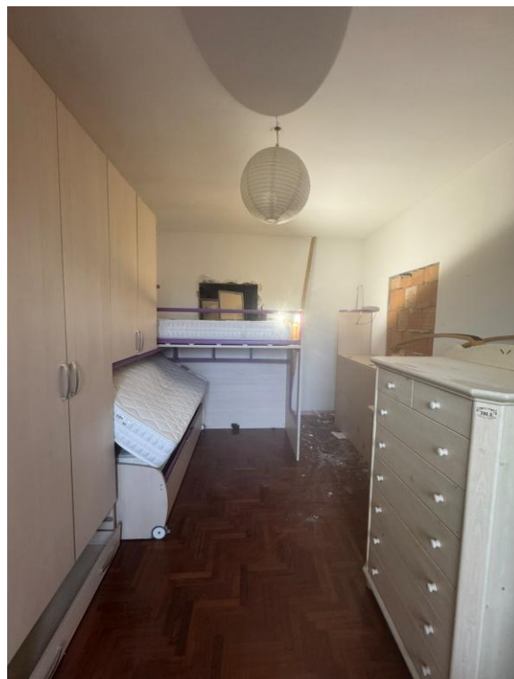
Seconda camera con particolare vano parto da intonacare e rasare
