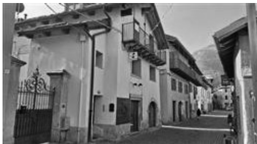
FABBRICATO LATO VIA ROMA
