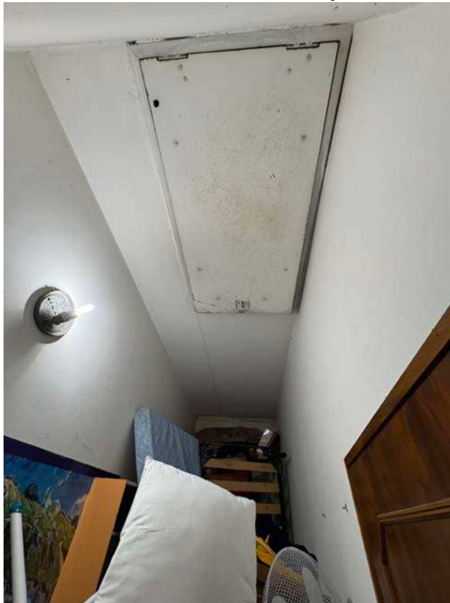
FOTO 13 (vista interna su botola di accesso al piano sottotetto)
