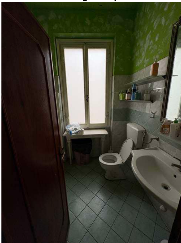
FOTO 15 (vista interna su servizio igienico)
