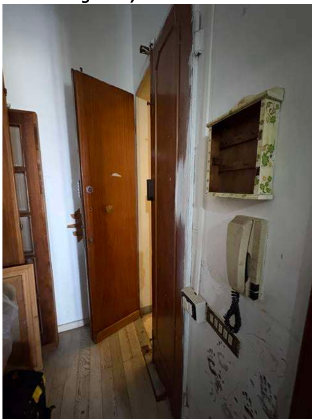
FOTO 4 (vista interna su ingresso)
