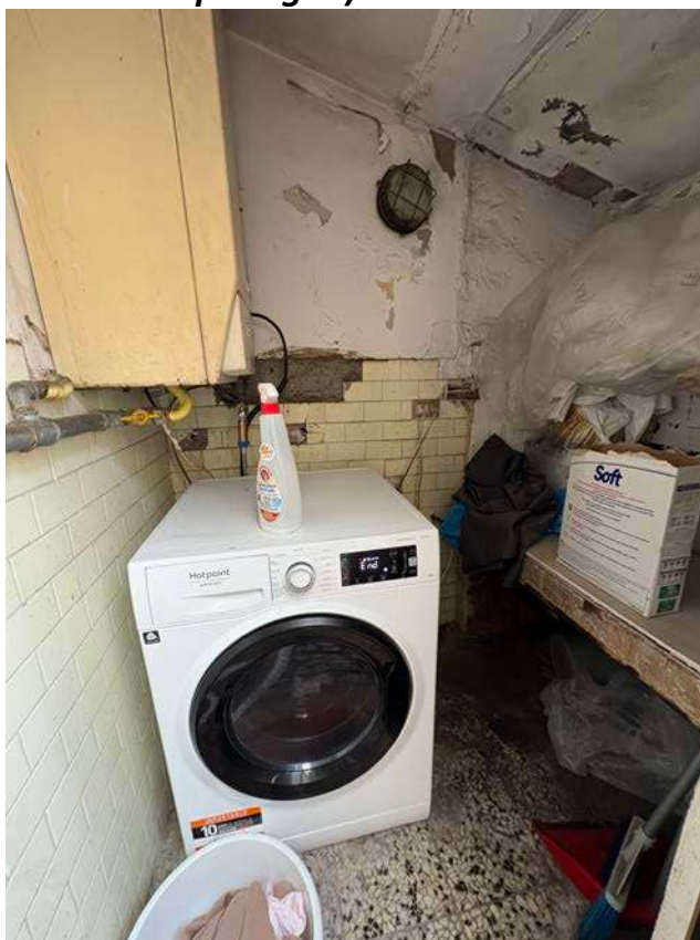
FOTO 18 (vista interna su ripostiglio)
