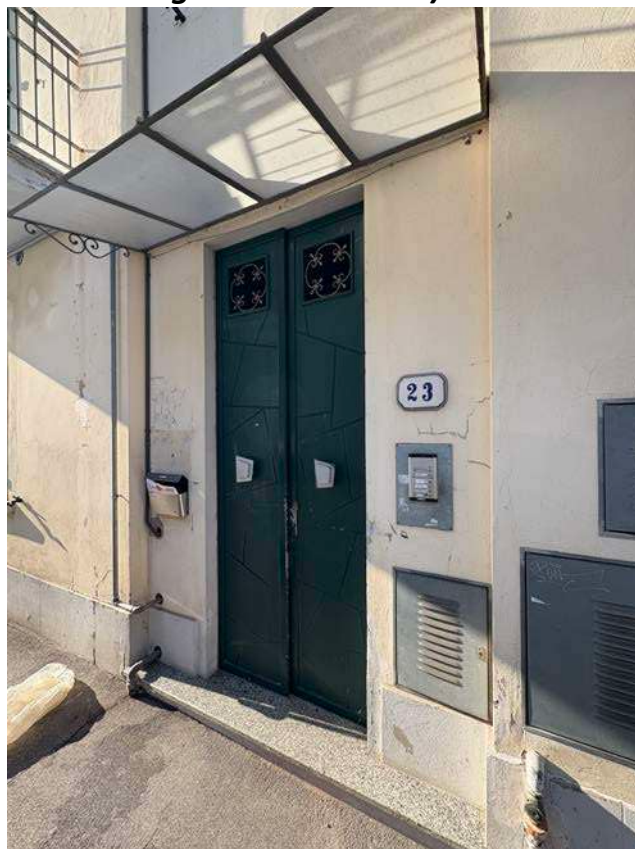
FOTO 2 (vista esterna su ingresso a comune)
