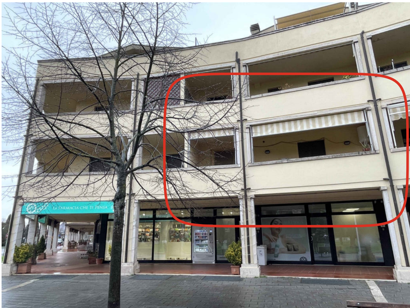
Vista del fabbricato da sud
