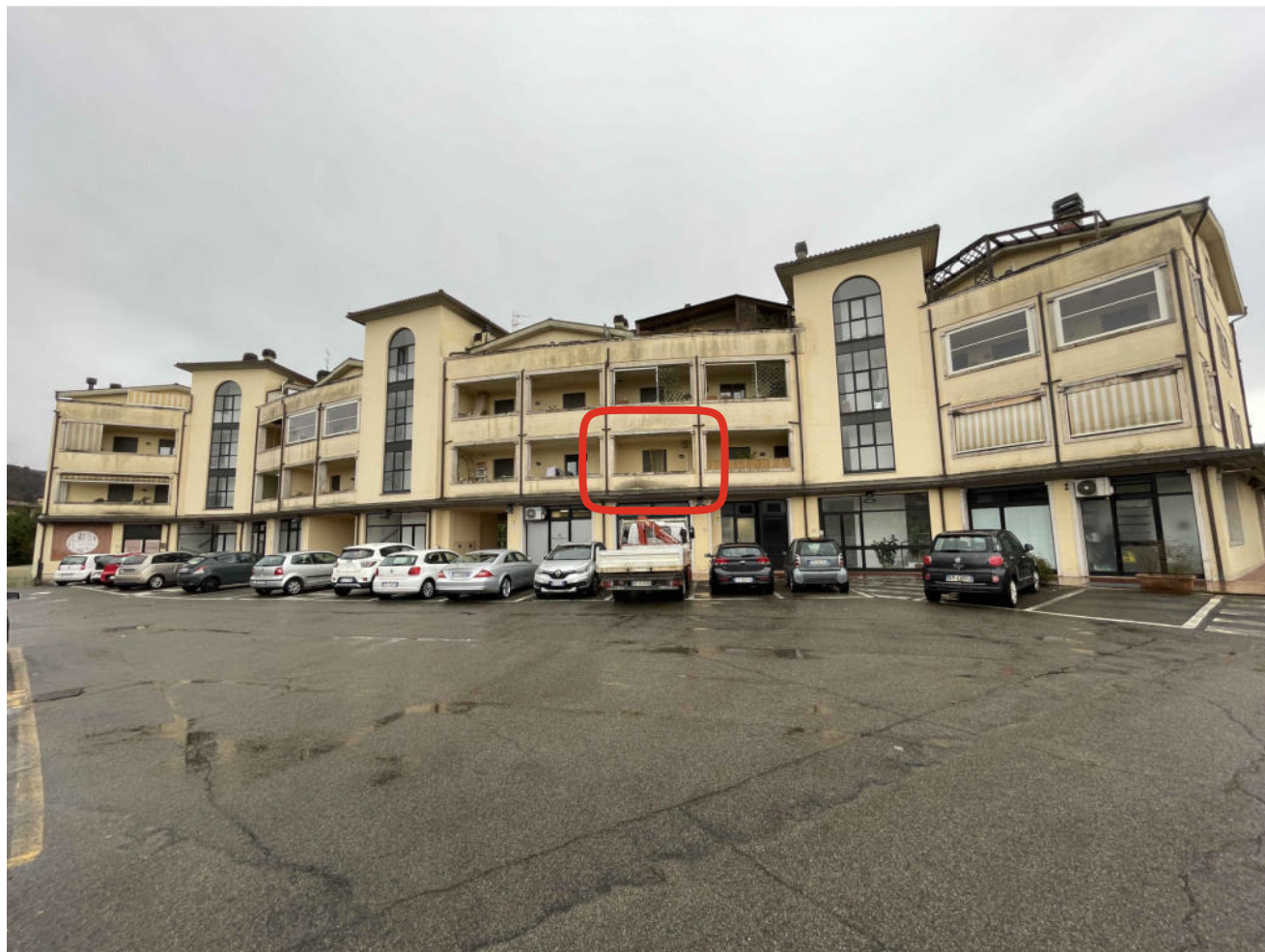
Vista del fabbricato da nord
