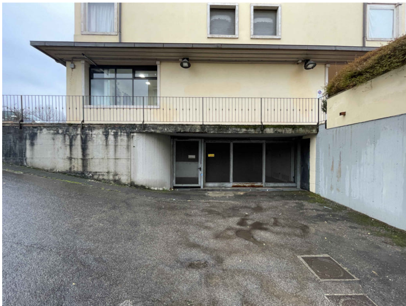
Vista dell'accesso al piano seminterrato (autorimesse)
