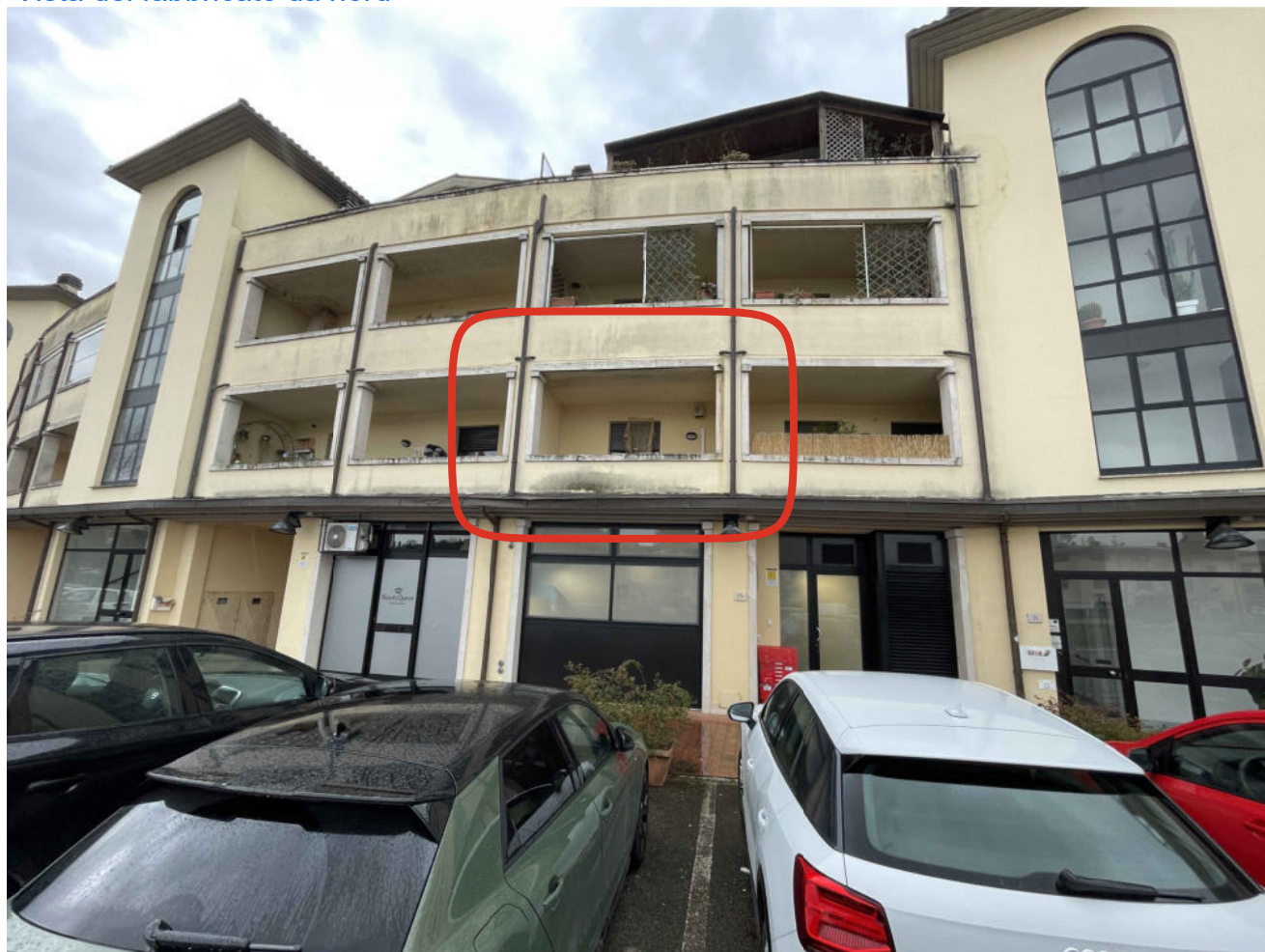
Vista del fabbricato da nord
