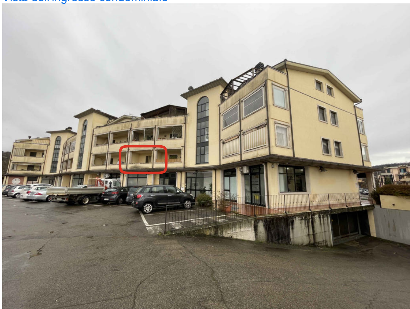
Vista del fabbricato da nord-ovest e della rampa di accesso al piano seminterrato
