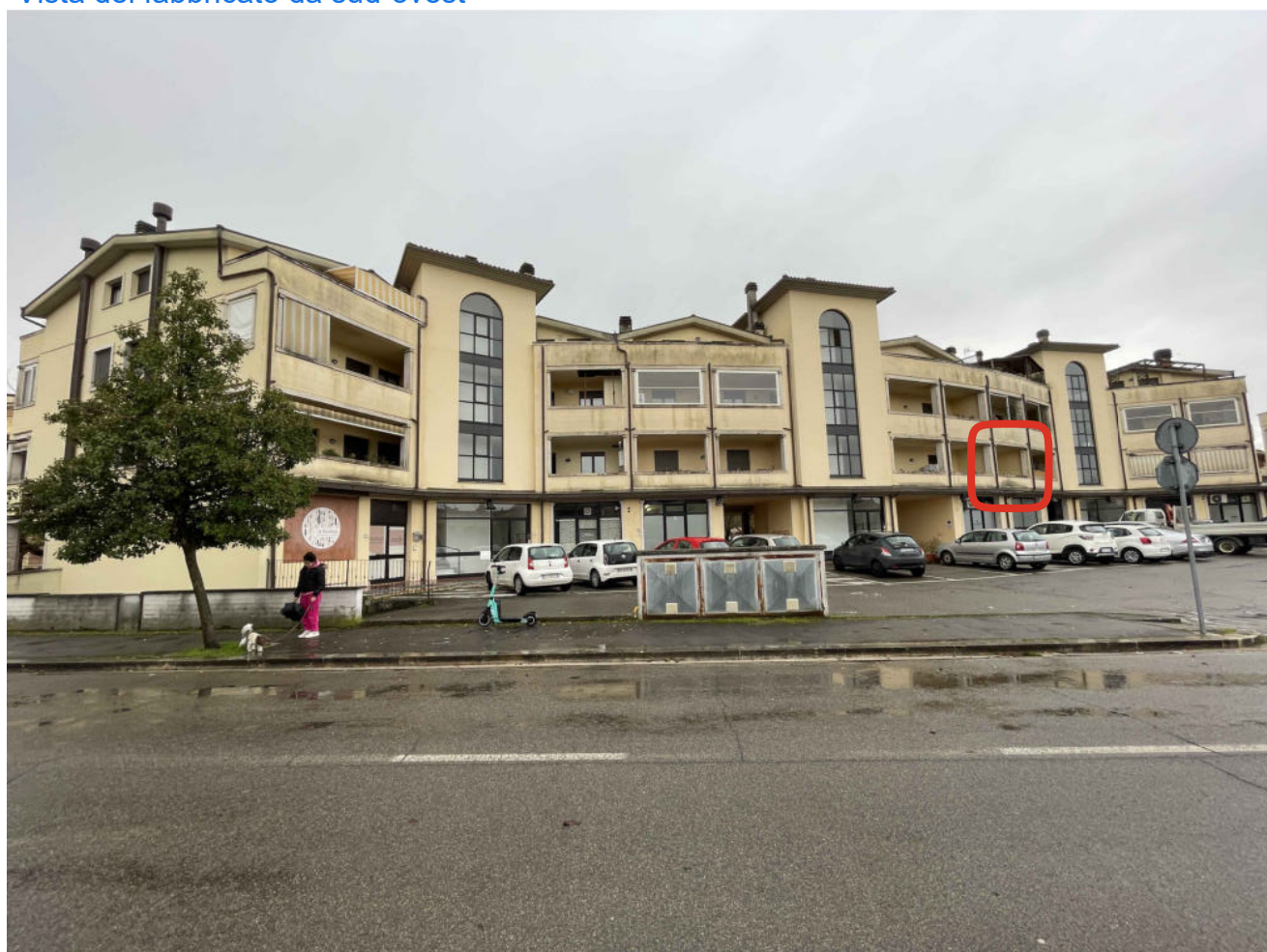
Vista del fabbricato da nord-est
