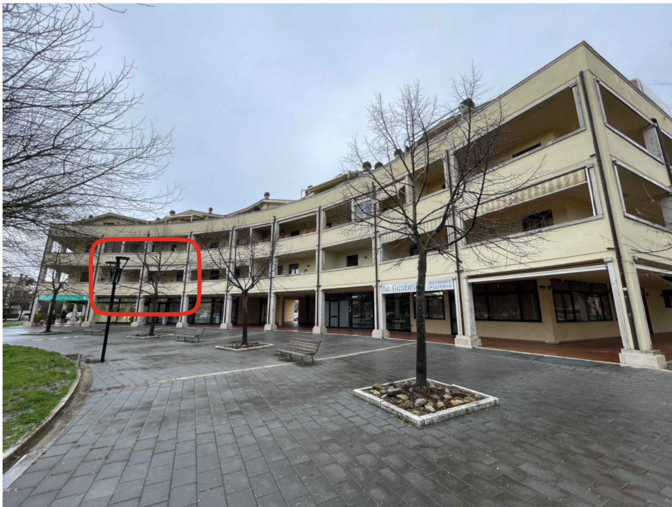
Vista del fabbricato da sud
