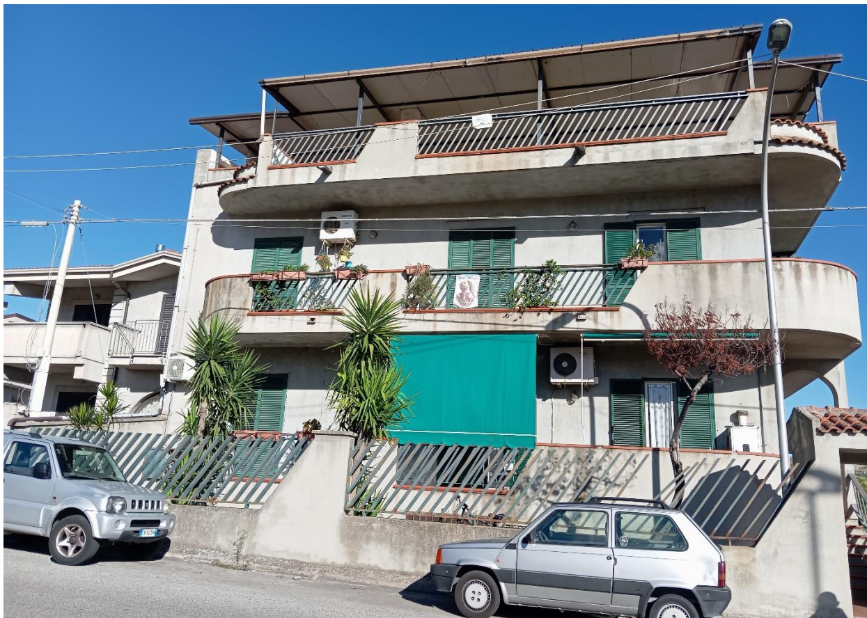
Foto 1: Prospetto fabbricato lato via Madama Lena
