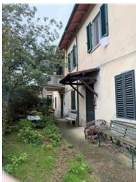
Vista tergale edificio
