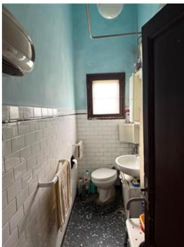
Vista servizio igienico
