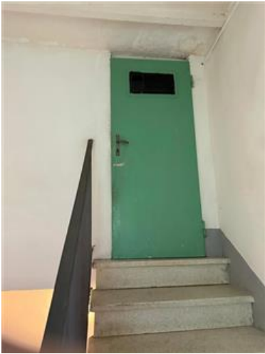
Vista ripostiglio esterno -1
