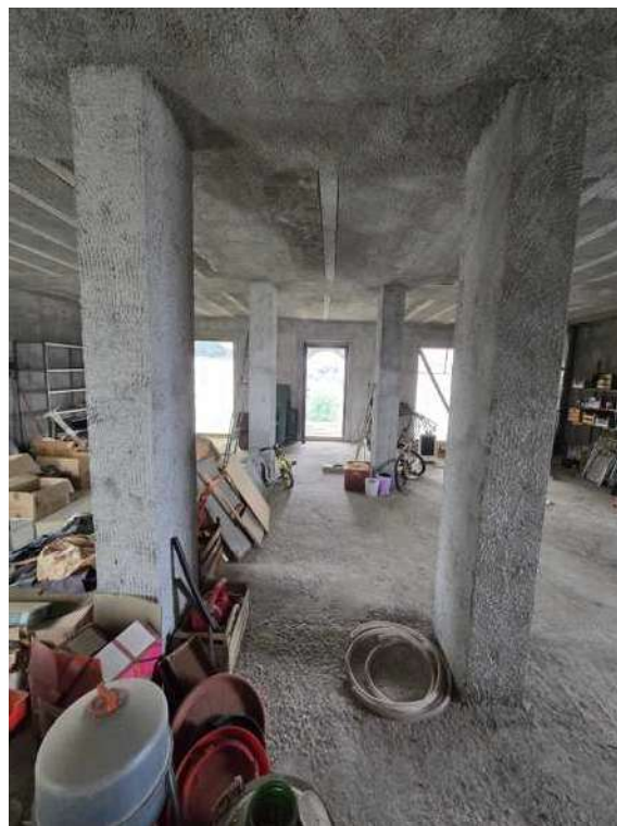
Foto 22: vista verso ingresso lato sud
