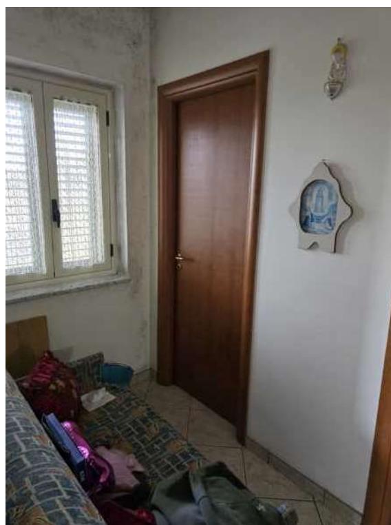
Foto 17: vista ingresso scala
