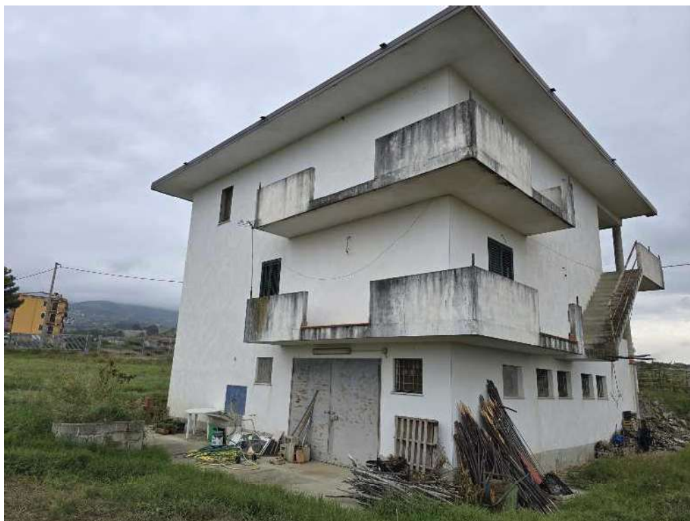
Foto 3: prospetto nord – ovest
