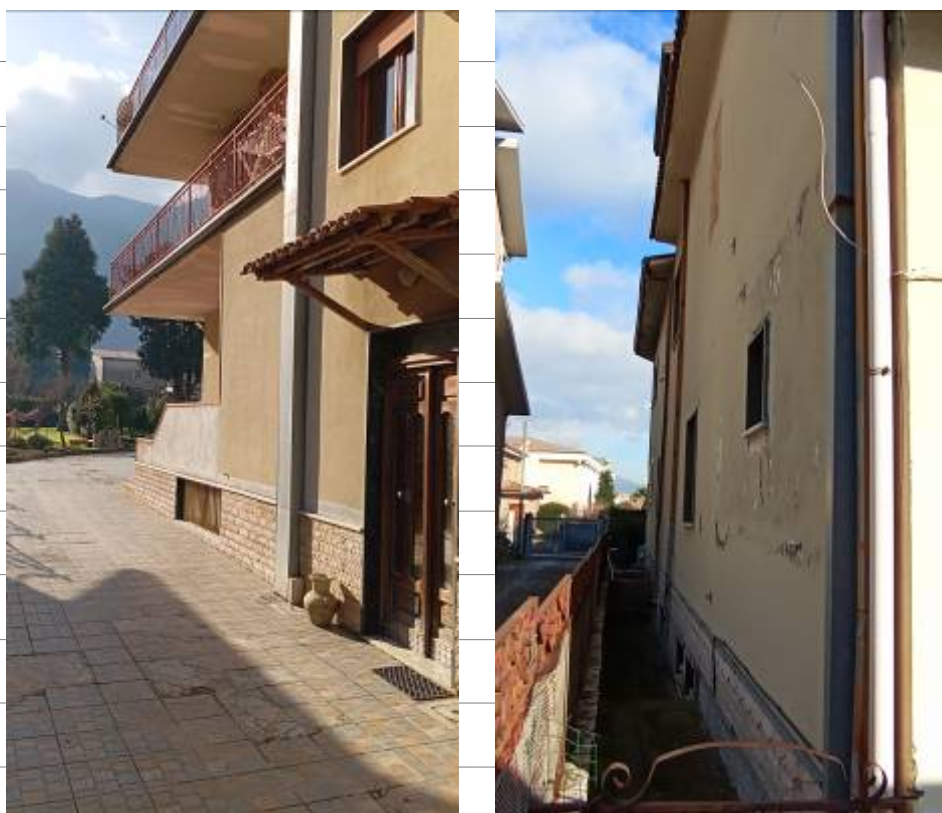
Foto 1 – 2_ Viste dalla corte pertinenziale dei lati est ed ovest del fabbricato
