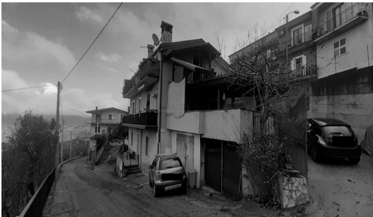
FOTO ESTERNE ACCESSO CARRAIO
