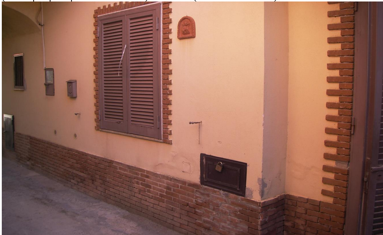
(foto 3: prospetto porzione fabbricato)
