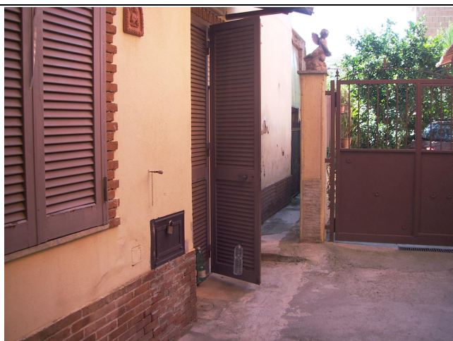
(foto 1: prospetto porzione fabbricato)
