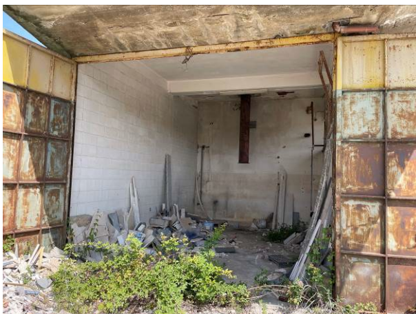
Foto 3 – locale ex centrale termica
