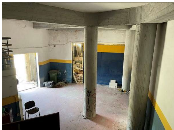
Foto 21 – androne di accesso
