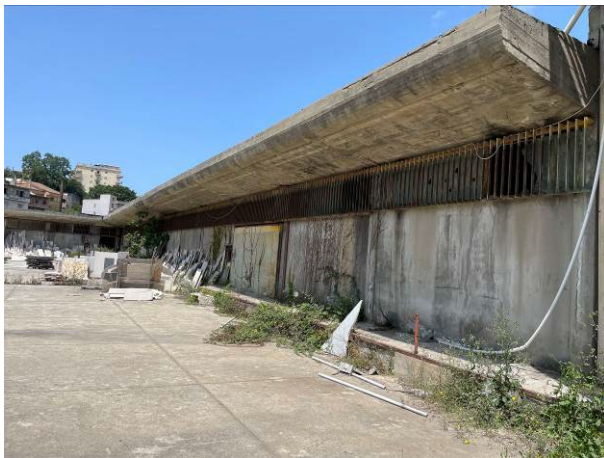
Foto 1 – prospetto del piano terra
