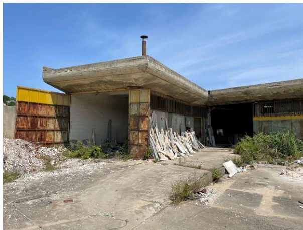
Foto 2 – prospetto del piano terra
