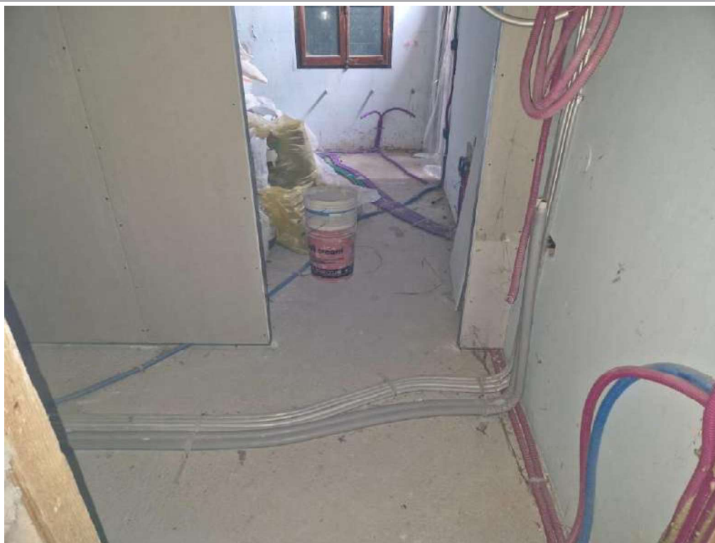
Foto 62 – vista corridoio e spogliatoio
