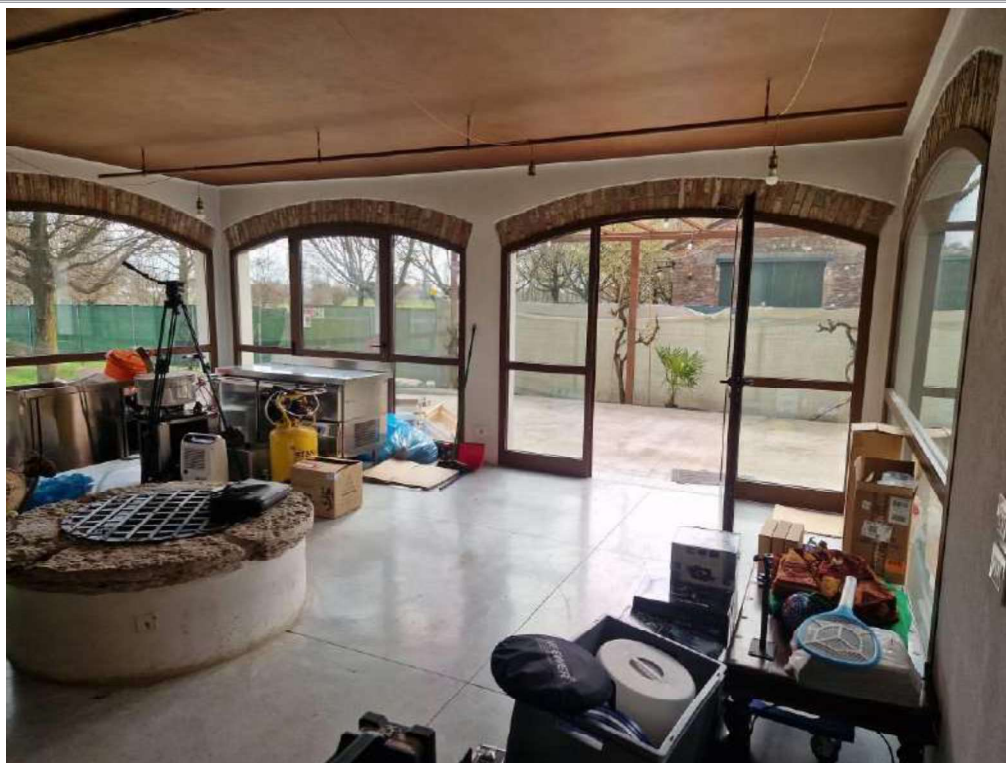
Foto 12 – vista sala ingresso
