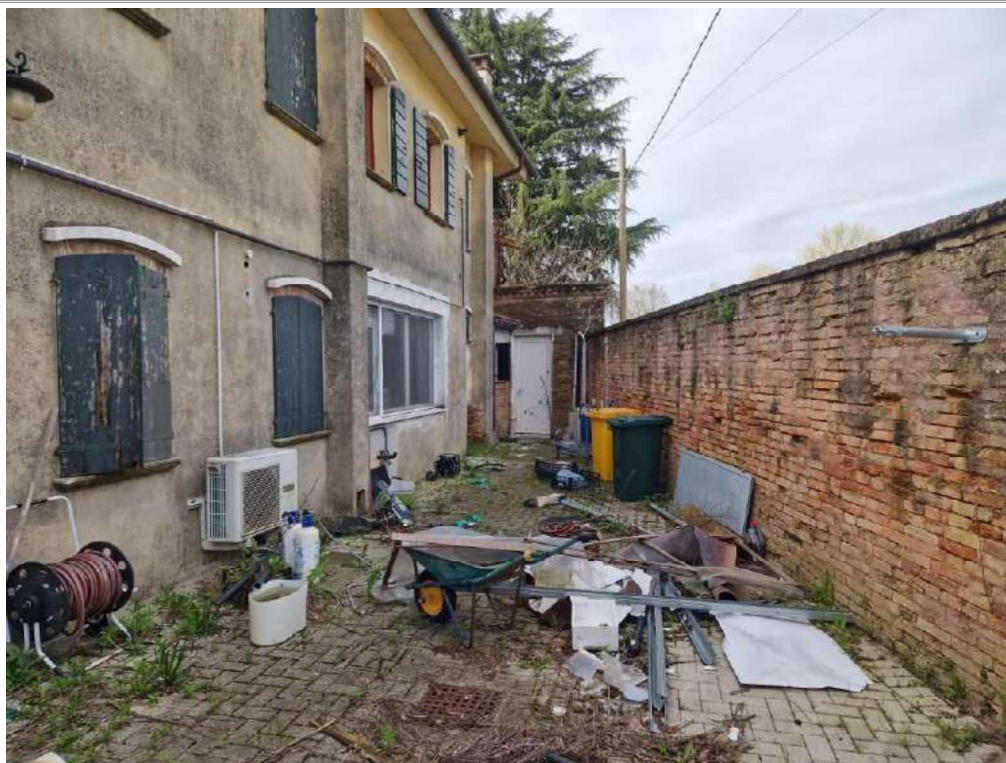
Foto 1 – vista cortile interno fronte nord
