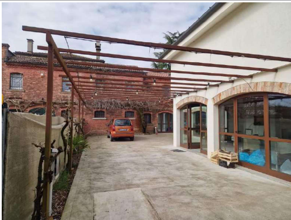
Foto 5 – vista scoperto esclusivo sud
