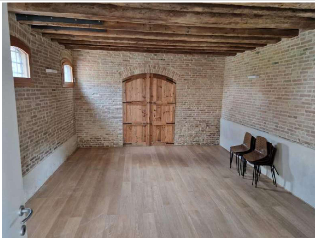
Foto 36 – vista sala somministrazione
