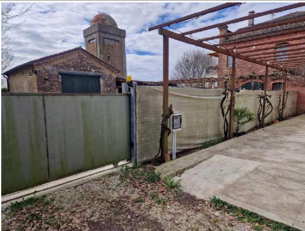
Foto 9 – vista confine sud e accesso altra unità immobiliare
