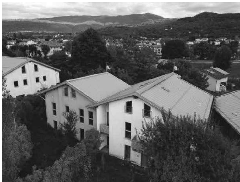
Vista fabbricati C2
