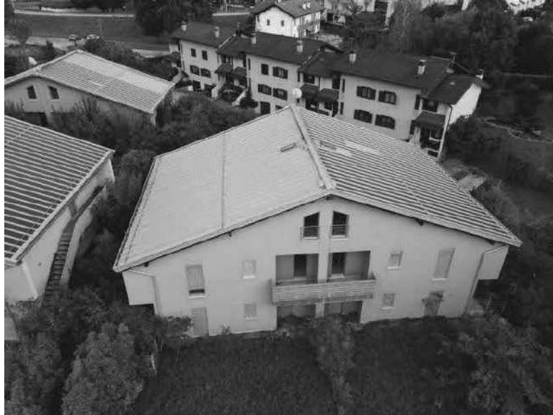
Vista fabbricato B1
