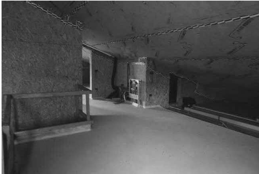
Vista sottotetto unità 11 fabbricato B2
