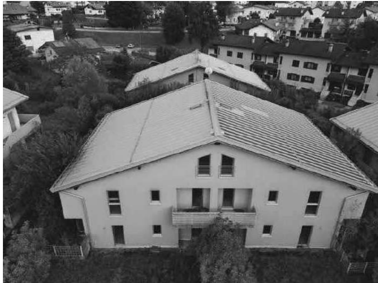
Vista fabbricato B2
