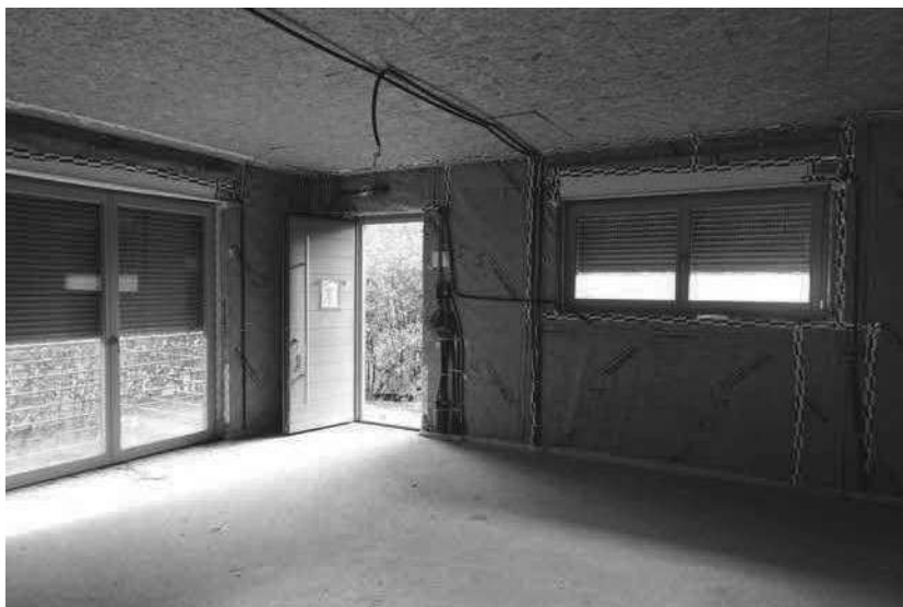
Vista al P.T. unità 5 fabbricato B1
