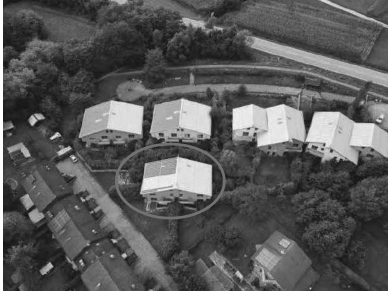
Vista dall'alto fabbricati con Fabbricato A
