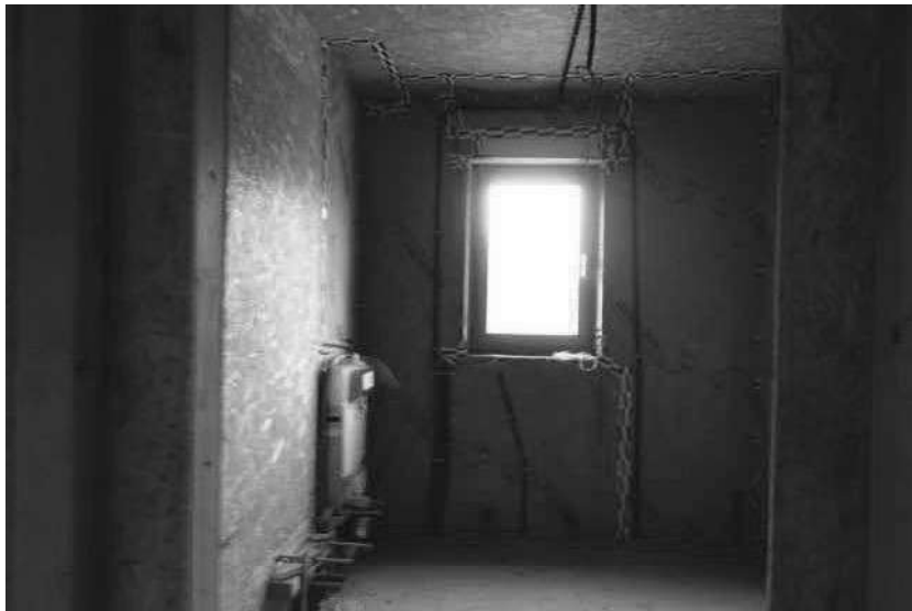
Vista bagno P.T. unità 11 fabbricato B2
