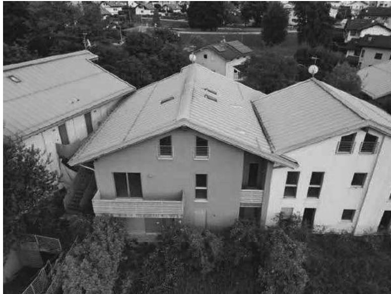
Vista fabbricati C1
