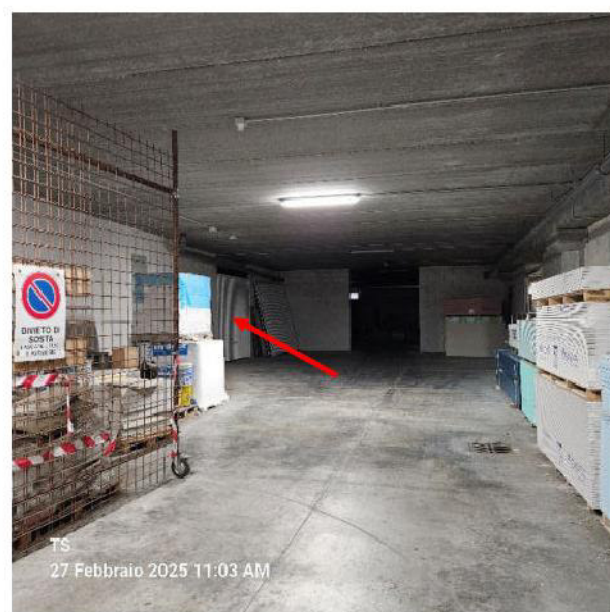
3 – corsia laterale (sub 77), accesso al sub 79
