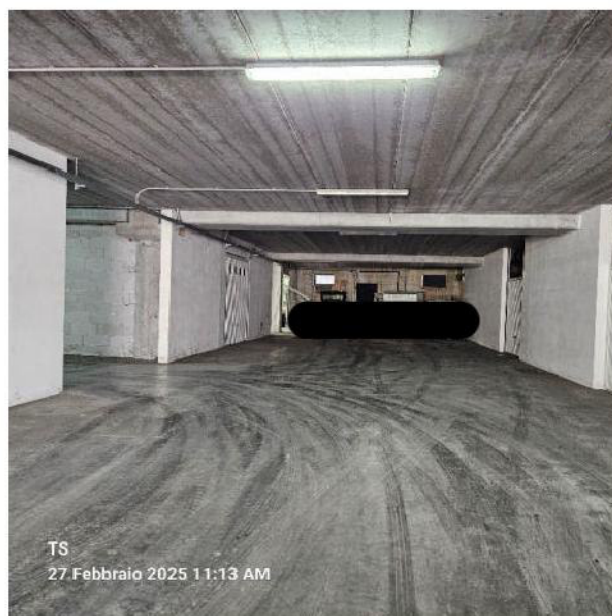
2 – corsia comune interna al piano (sub 19)
