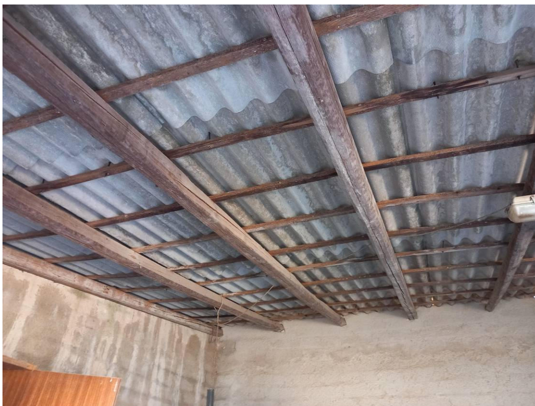
Foto 12: Particolare della copertura del locale deposito esterno
