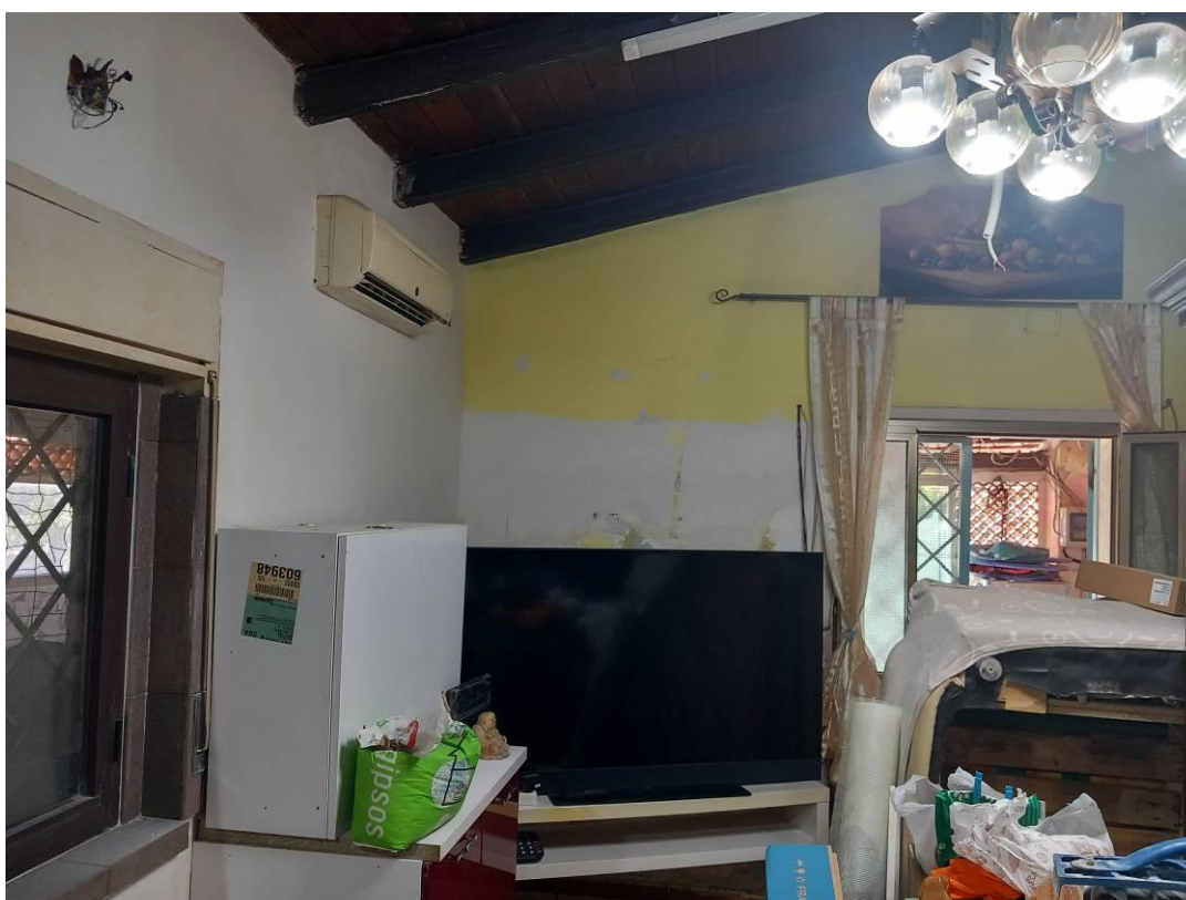
Foto 6: Vista della cucina/soggiorno
