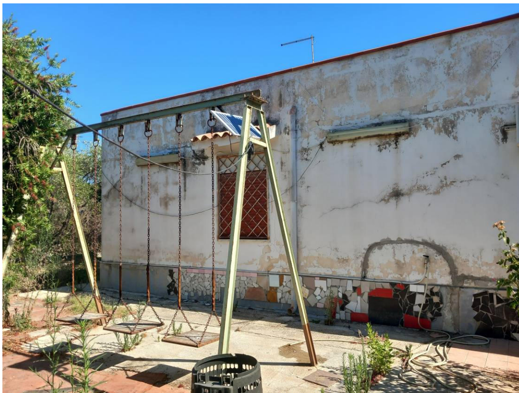
Foto 4: Vista del prospetto sud della villetta
