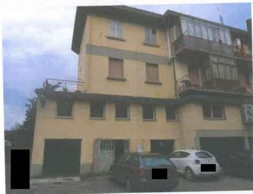
② VISTA ESTERNA, INGRESSO AL LABORATORIO
