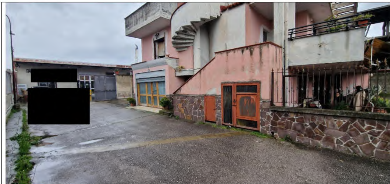
Foto n. 3 – Lotto 2 – Ingresso p.lla 871 sub 3 da viale comune
