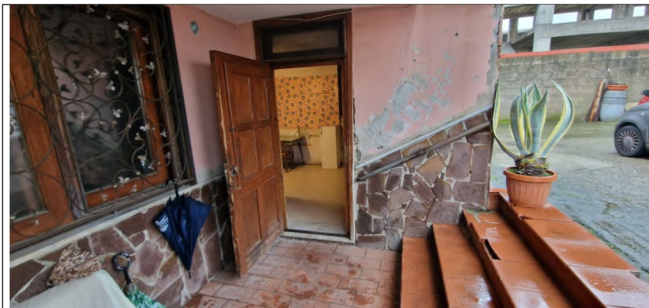
Foto n. 2 – Lotto 1 – Ingresso p.lla 871 sub 2
