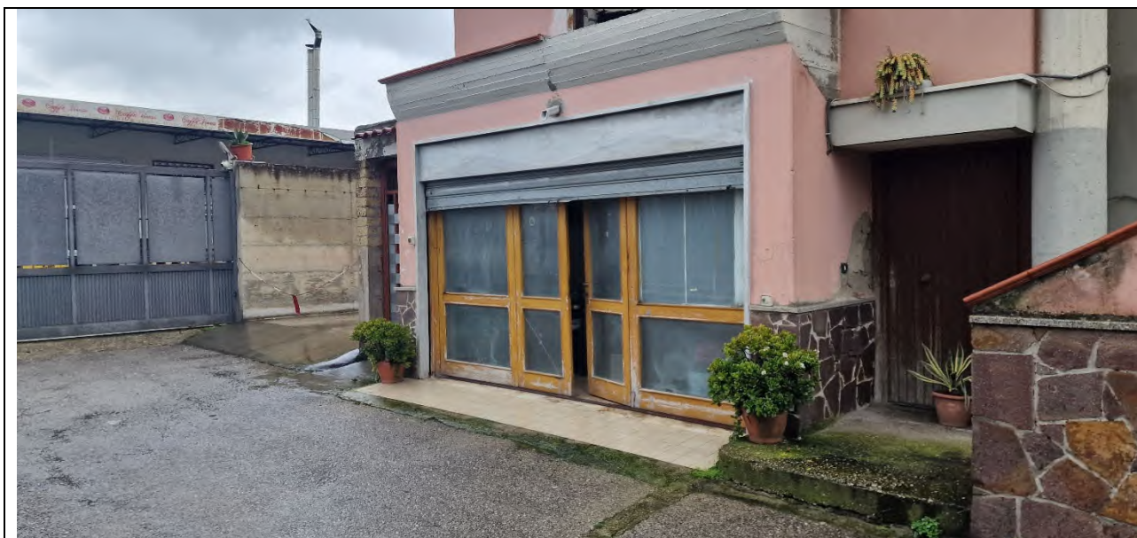
Foto n. 10 – Lotto 2 – Ingresso p.lla 871 sub 3
