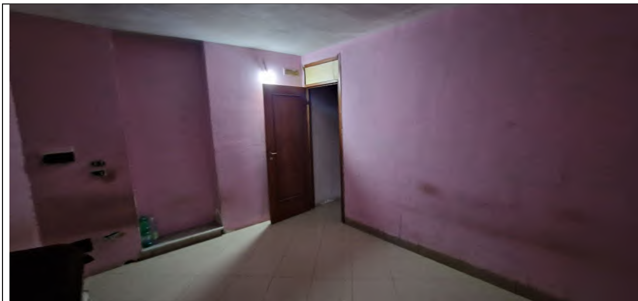
Foto n. 9 – Lotto 1 – Camera p.lla 871 sub 2 e porta murata
