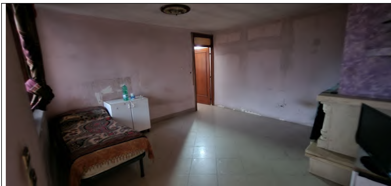
Foto n. 8 – Lotto 1 – camera p.lla 871 sub 2 e tramezzatura da demolire
