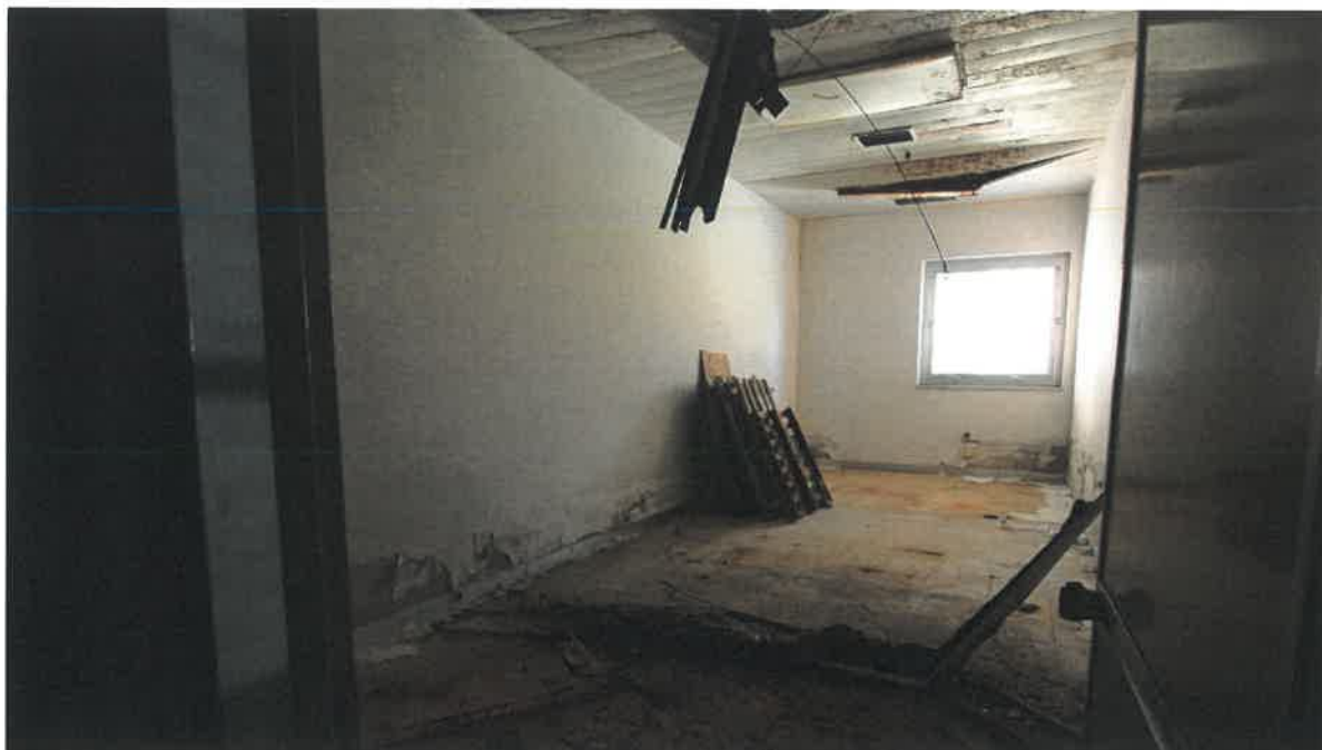
E33 - Interno locali
