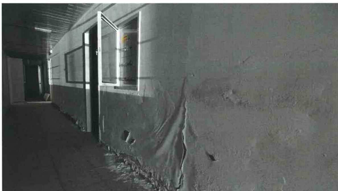
E33 - Interno locali
