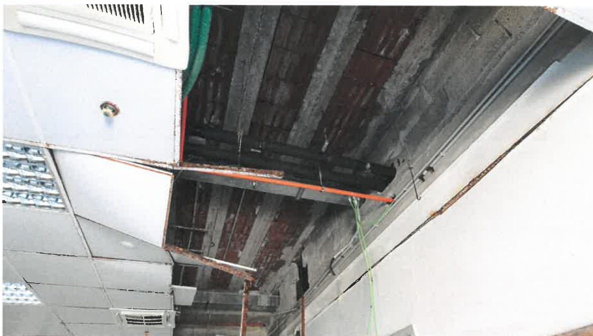
E33 - Interno locali, intradosso solaio
