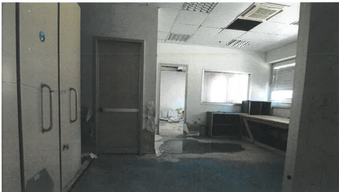
E33 - Interno locali
