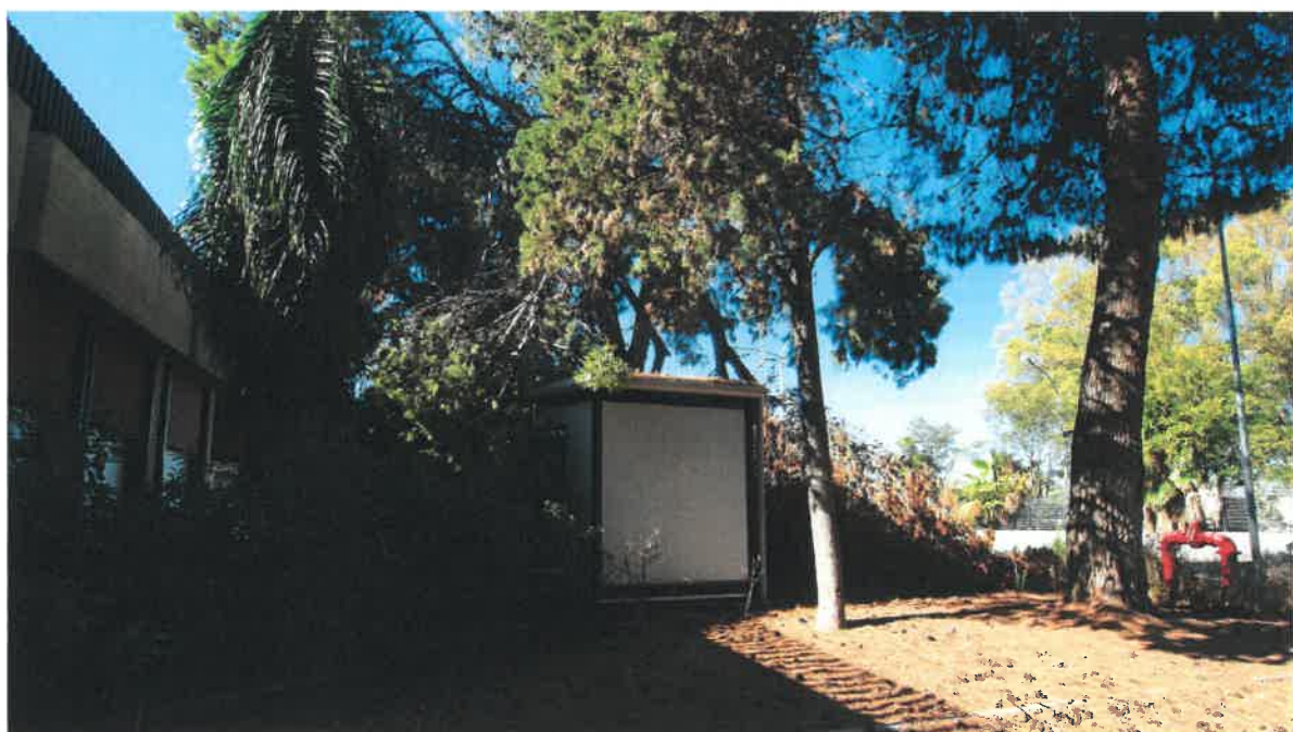
E55 - lato sud zona atrio di ingresso. Di fronte box fumatori. Evidente il mancato controllo della vegetazione
