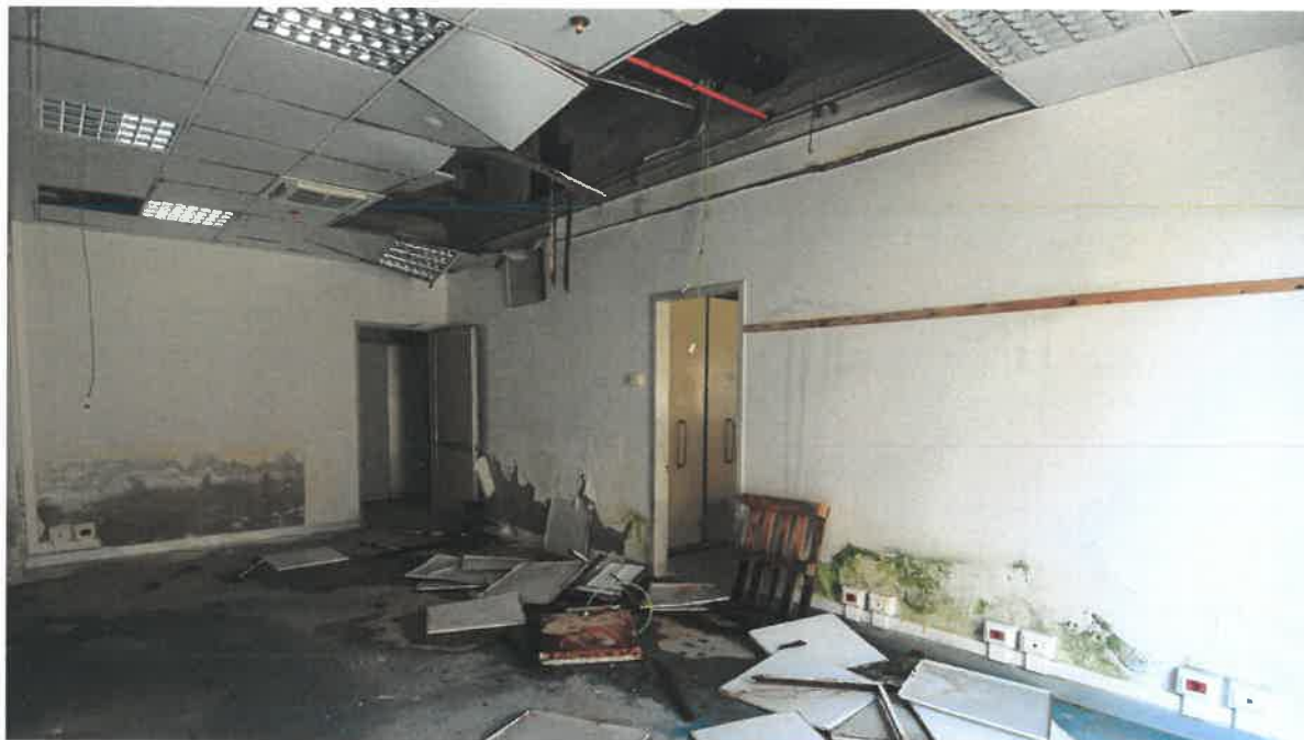
E33 - Interno locali
