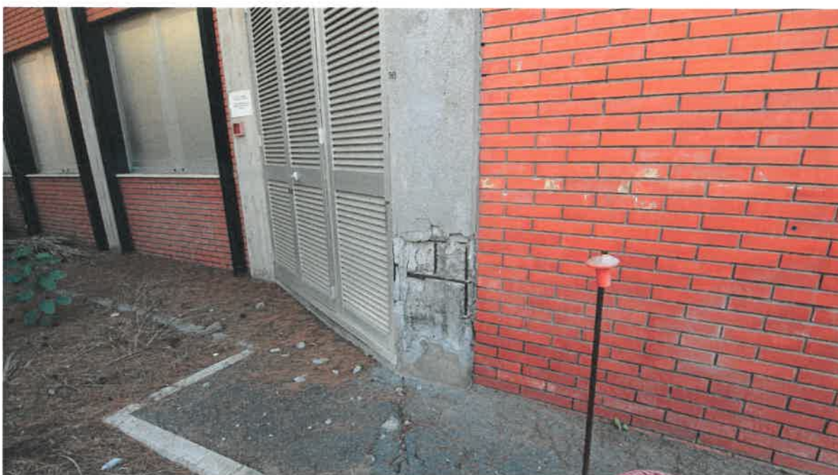
E33 - lato est. Condizioni prospetto e accesso centrali tecnologiche
