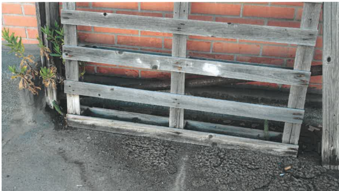
E55 - Lastrico solare: condizioni guaina impermeabilizzante
