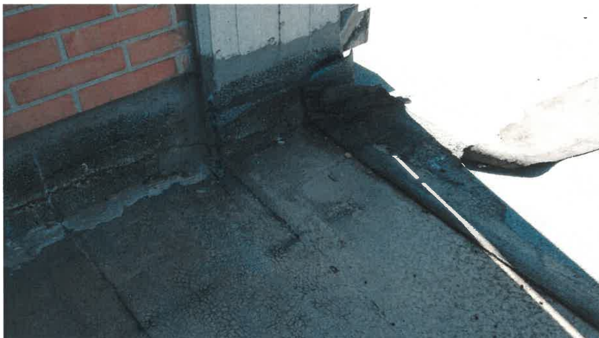
E55 - Lastrico solare: condizioni guaina impermeabilizzante
