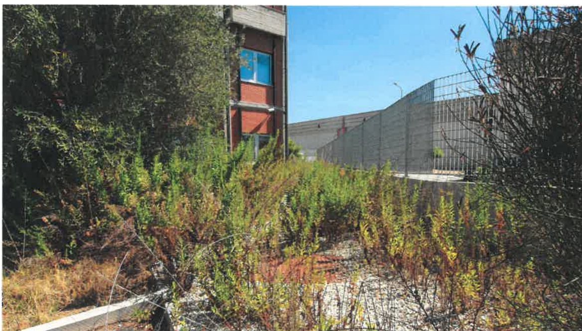
E55 -Lato Est verso recinzione verso stabilimento Pfizer
