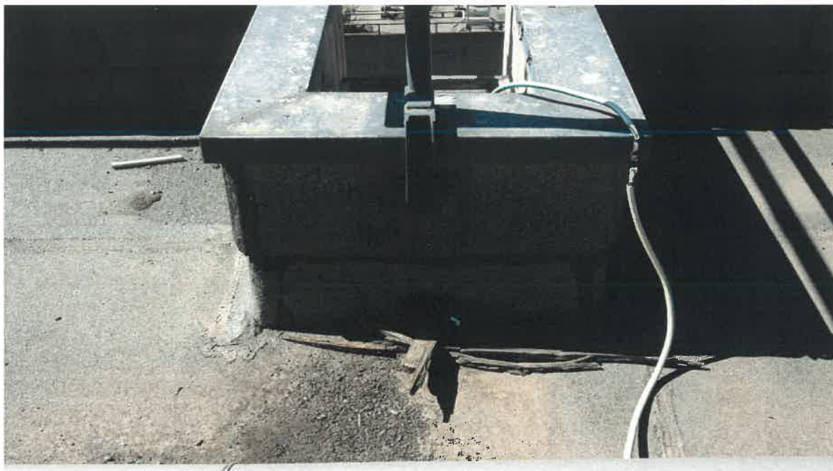
E55 - Lastrico solare: Imbocco pluviale discendente
