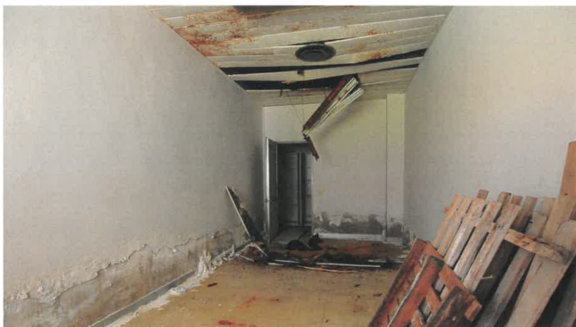
E33 - Interno locali
