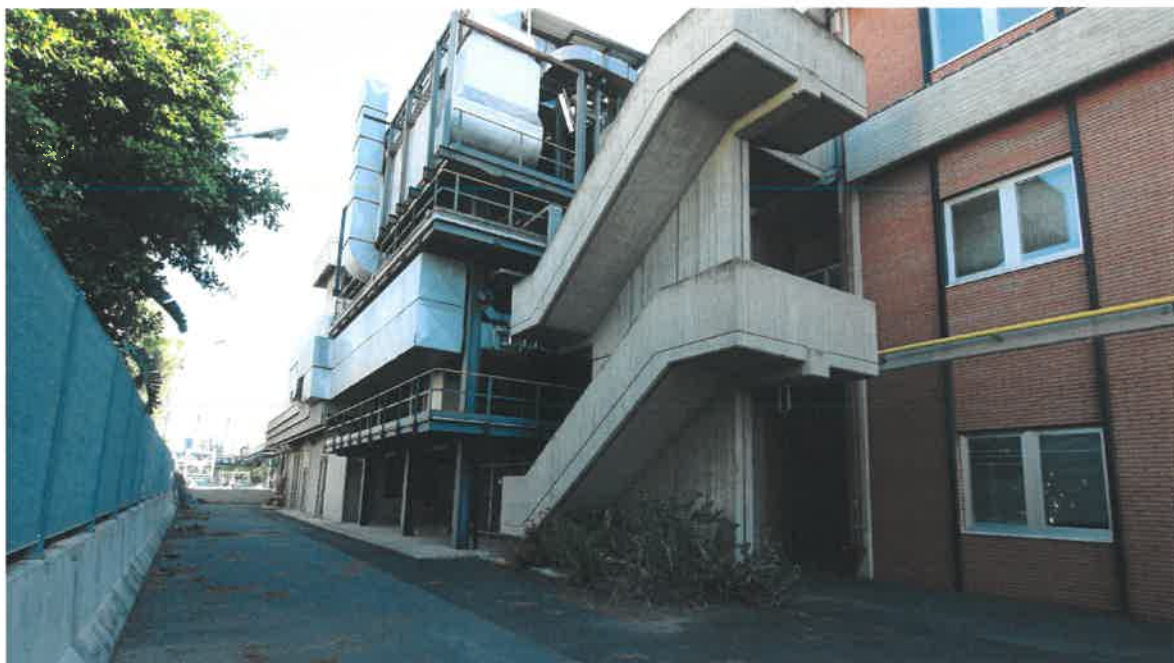
E55 - lato ovest. Scala di emergenza e rack ovest
