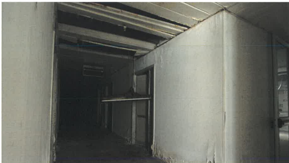
E33 - Interno locali
