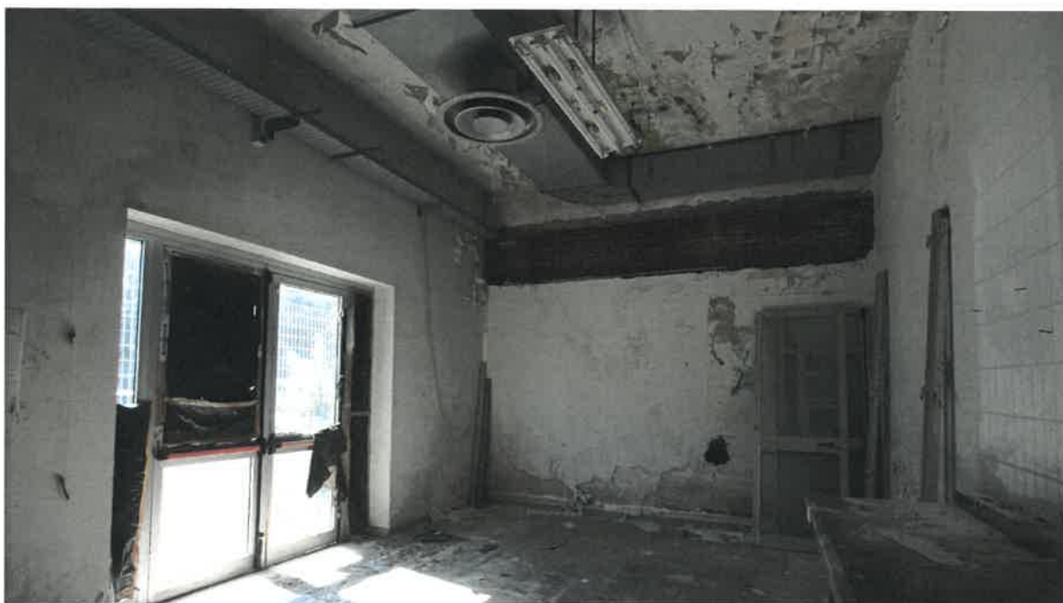
E33 - Interno locali
