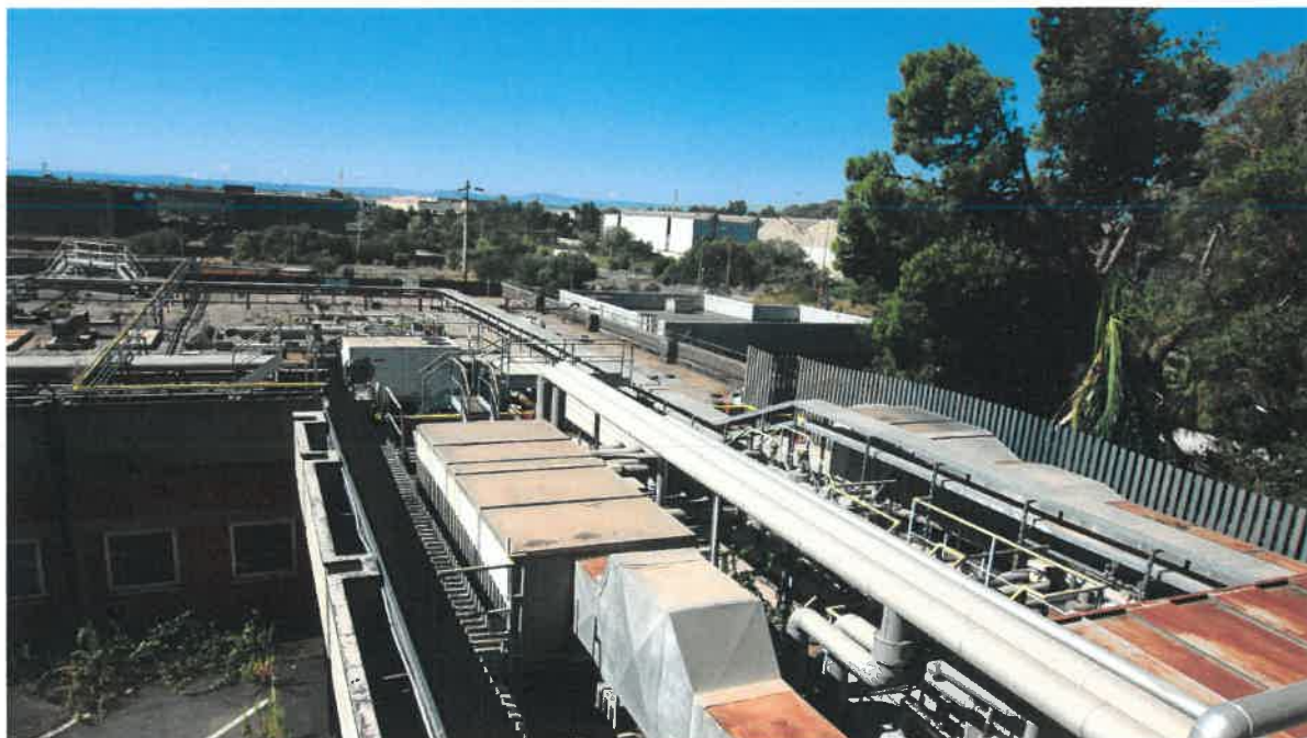
E33 - Vista della terrazza di copertura
