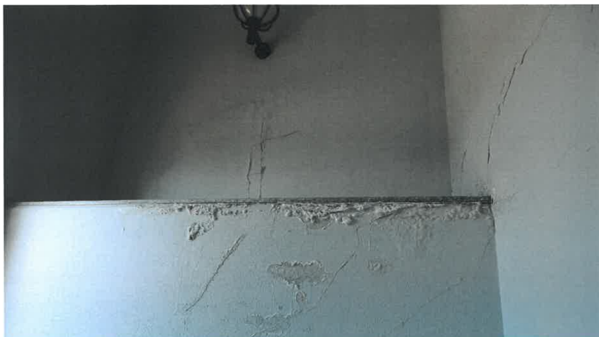
E55 - Corpo scala lato lato ovest sottostante la terrazza di copertura
