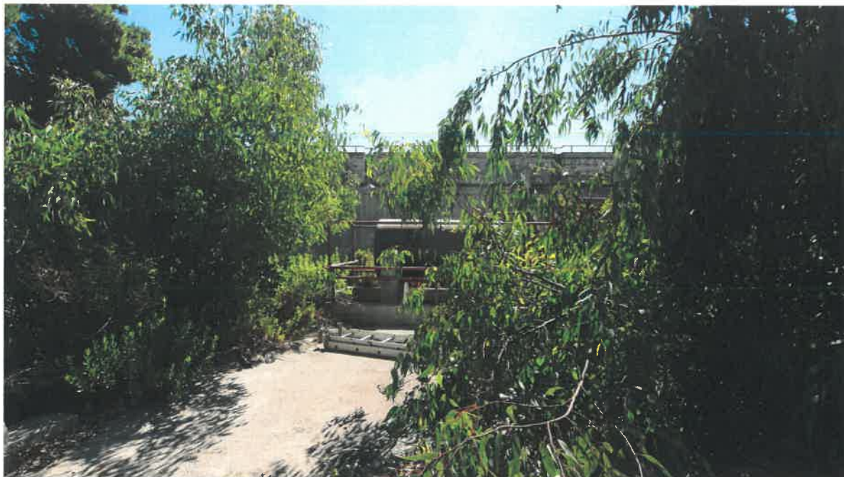
Serbatoio stoccaggio gasolio e retrostante riserva idrica
