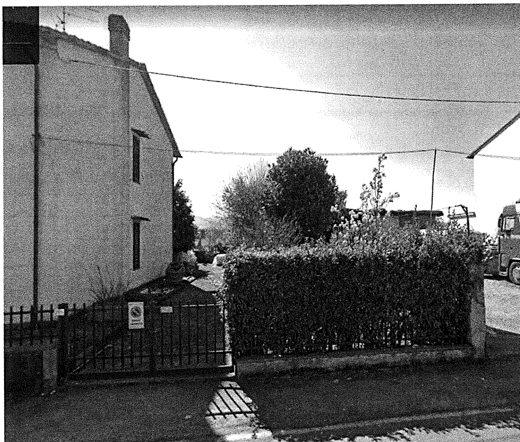
Illustrazione 4: prospetto dell'area urbana ove si evince il cancello di accesso
